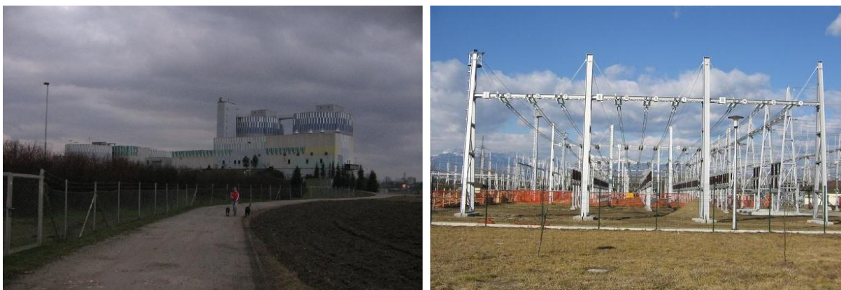
Slika 14: Centralna čistilna naprava Zalog (levo) in razdelilna transformatorska postaja Beričevo (desno)
