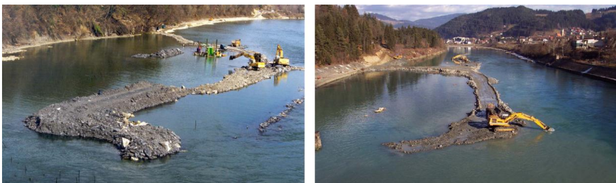
Slika 49: Prikaz izvedbe poglobljanja struge pod HE Vuzenica (vir: Rajh, Dobnikar, Milič, 2002)
