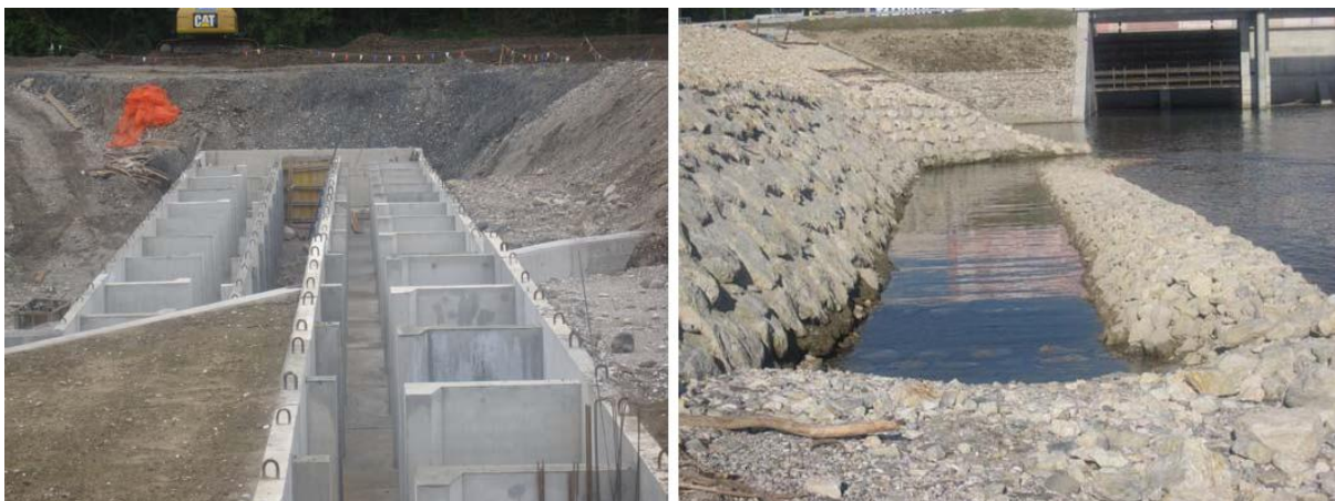
Slika 54: Primer ureditve vtočnega (levo) in iztočnega dela (desno) ribje steze na HE Blanca (vir: HESS d.o.o. Brežice, 2010)
