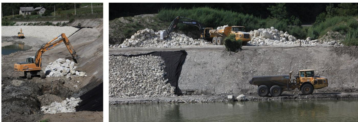
Slika 51: Prikaz izgradnje skalometa vzdolž akumulacije HE Krško (vir: http://www.he-ss. )
