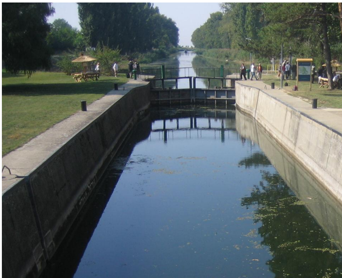
Slika 15: Vodna zapornica Mali Stapar v hidrosistemu DTD (avtorska fotografija, 2009).
