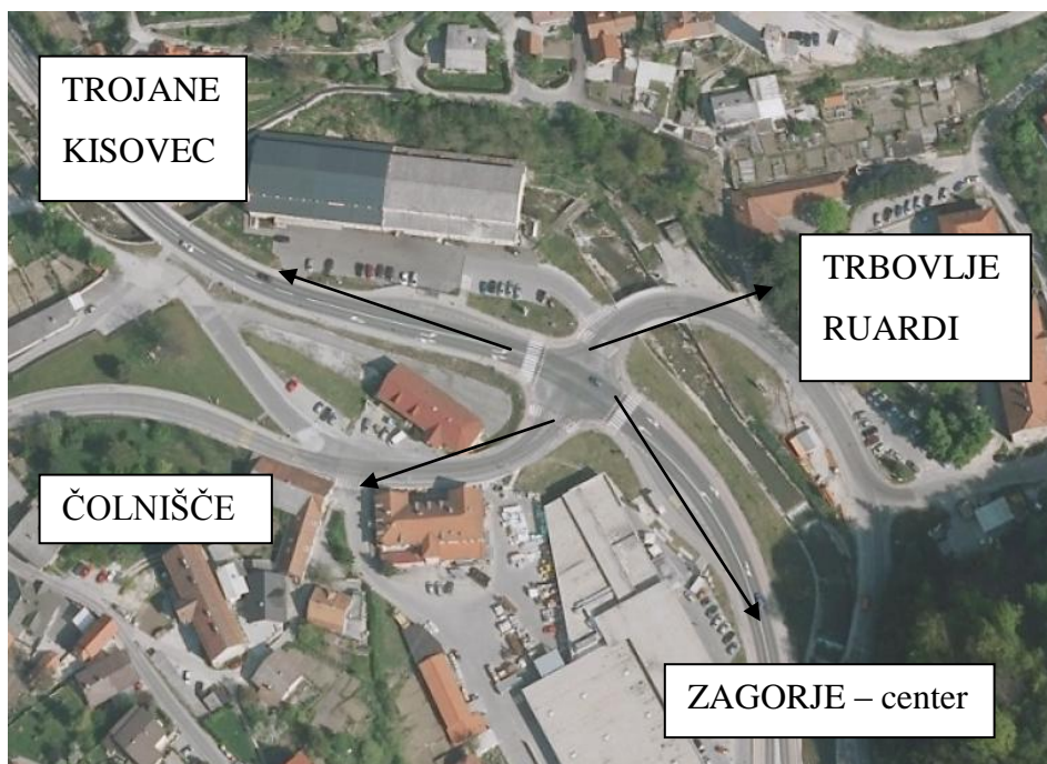
Slika 27: Pogled na križišče iz zraka
