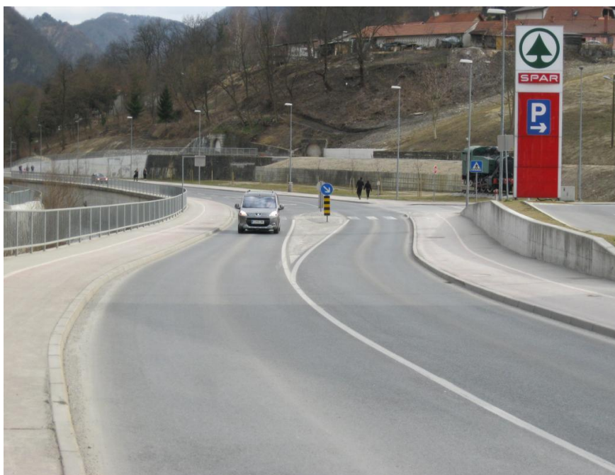
Slika 34: Pogled na križišče pri uvozu za Spar
