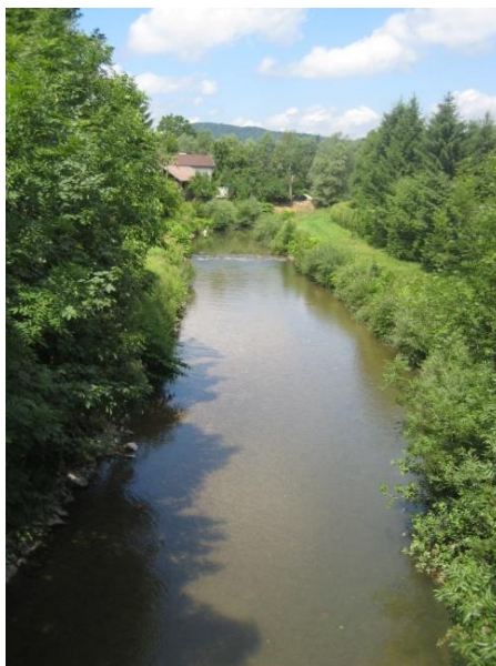
Slika 7: Mali graben je umetno urejen razbremenilni kanal reke Gradaščice, ki je bil izkopen zaradi pogostega poplavljanja ljubljanskega mestnega predela Trnovo. (Wikimedia, 2012)
