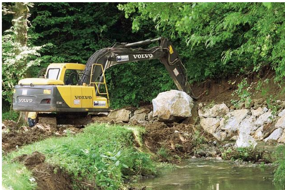
Slika 24: Bager pri urejanju brežine (Krajnc, 2002)
