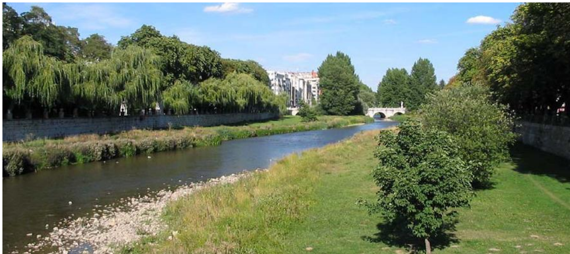
Slika 19: Primer zelenega pasu ob reki v mestu v času nizkih voda; ob robovih je viden betonski zid, ki zadrži poplavne vode; Burgos, Španija (Balant, 2006)
