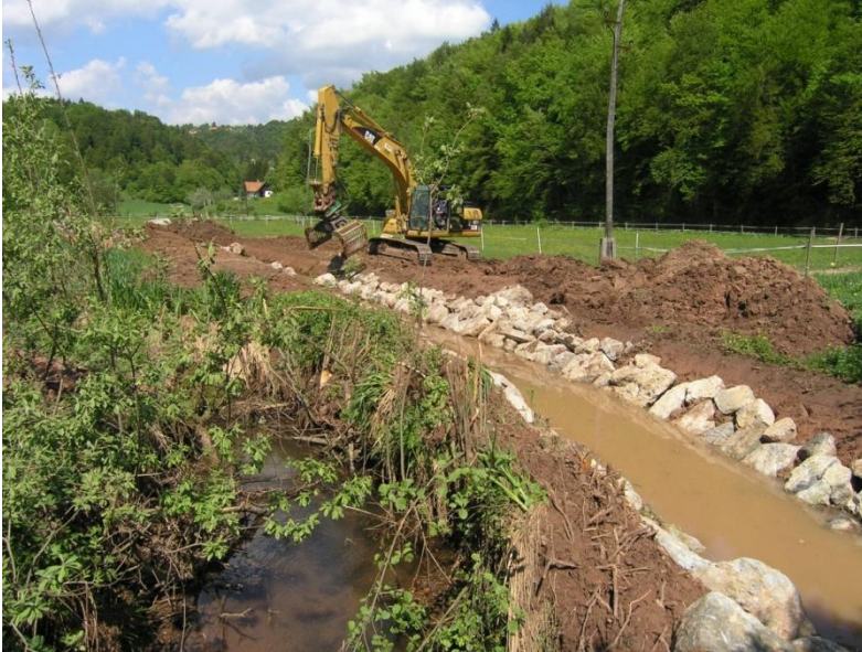
Slika 16: Izdelava kamnometa (Milan Pušljar s.p., 2012)
