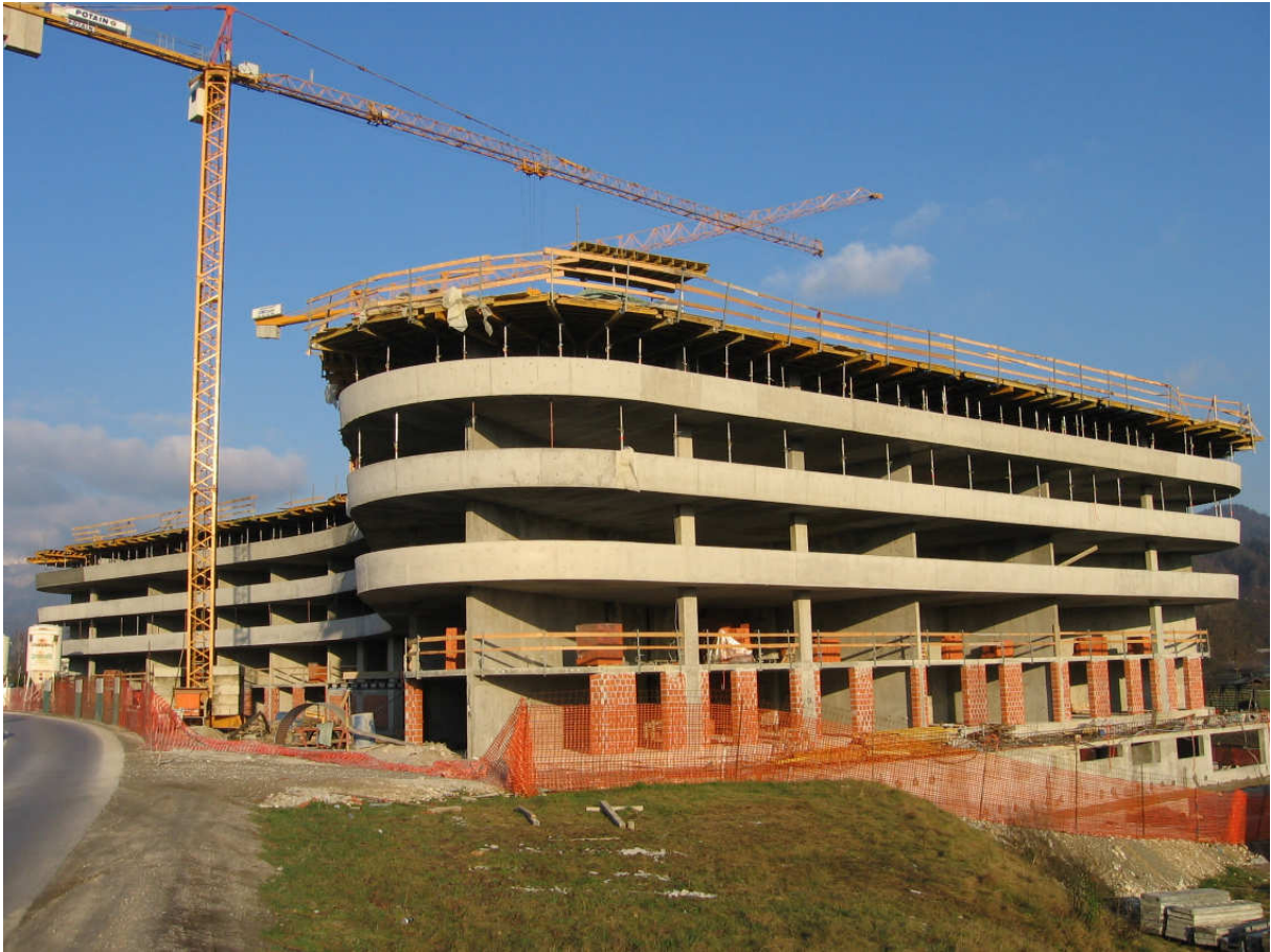
Slika 1: Objekt Metuljček v fazi gradnje – pogled s tal (20.12.2006)
