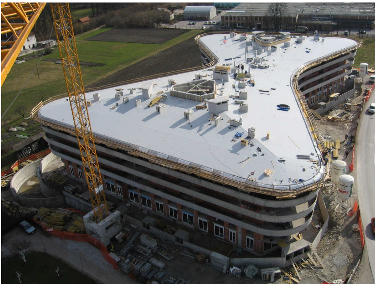
Slika 2: Objekt Metuljček v fazi gradnje – pogled z žerjava (27.02.2007)
