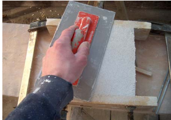
Slika 46: Izdelava fine zaribane malte
