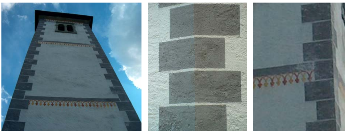
Slika 8: Apneni premazi na star apnen omet (Cerkev sv. Miklavža v Mevkšu)
