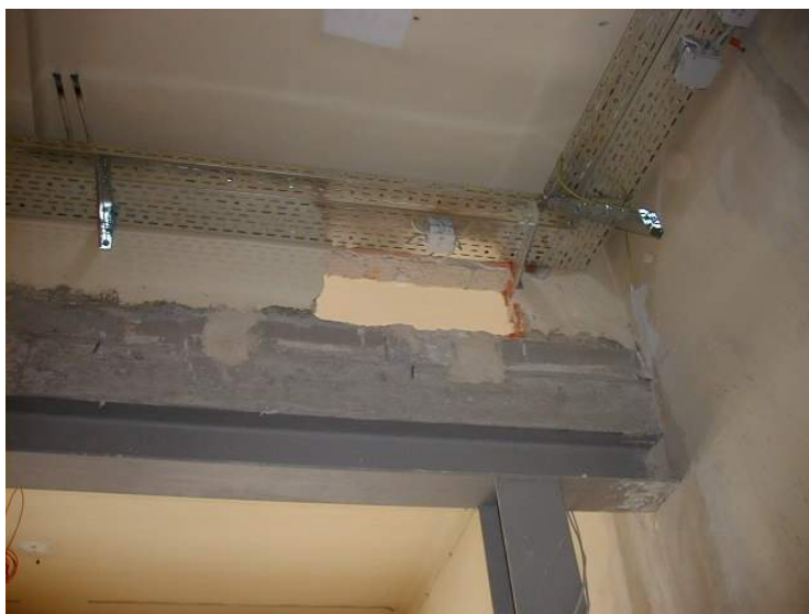
Slika 10: Vgradnja jeklenih nosilcev
