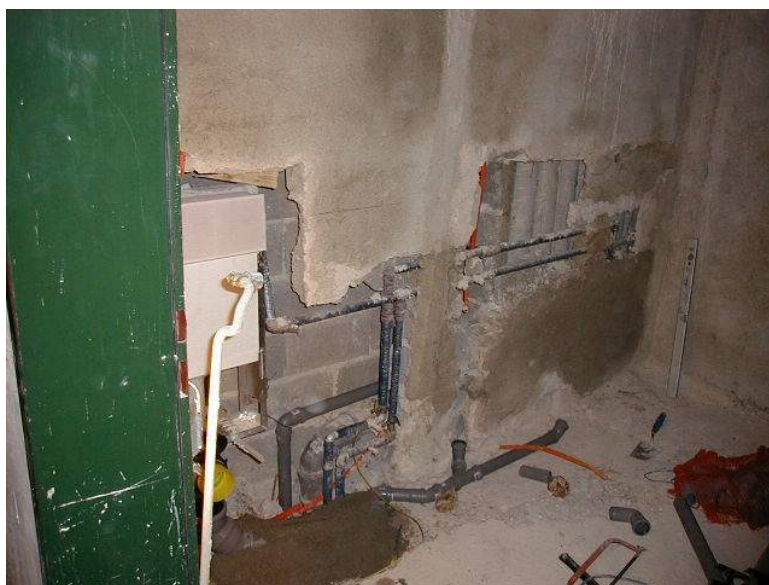
Slika 11: Sanacija vodovodnih inštalacij
