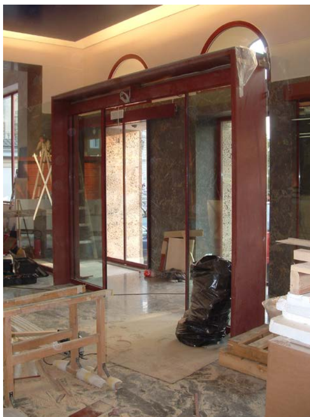
Slika 12: Obnova glavnega vhoda lekarne
