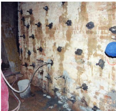
Slika 36: Detajla injektiranja zidu (Bergant in sod., 2012)
