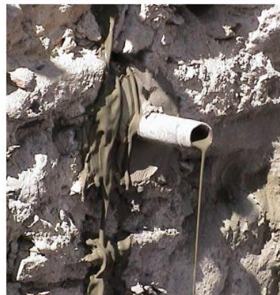
Slika 36: Detajla injektiranja zidu (Bergant in sod., 2012)
