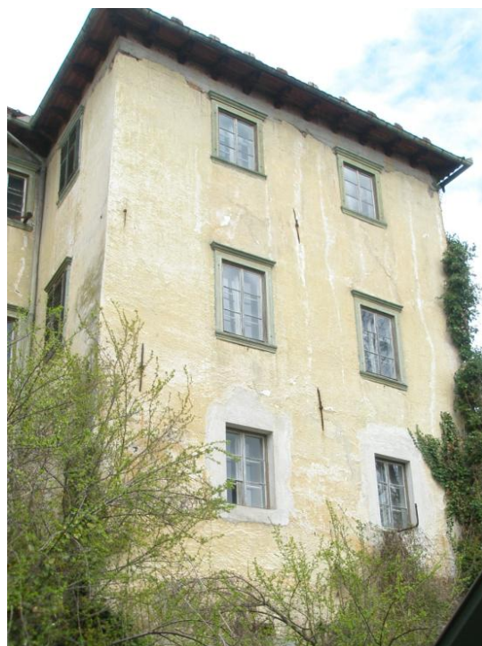
Slika 12: Zidne vezi na fasadi stolpa
