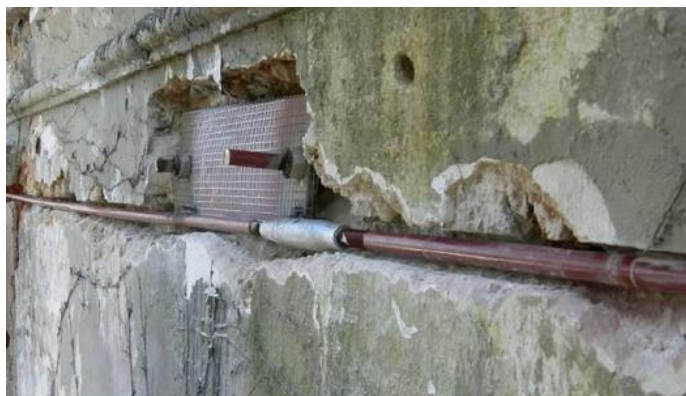
Slika 24: Detajl pritrdjevanja in vgrajevanja zidnih vezi (Bergant, 2012)
