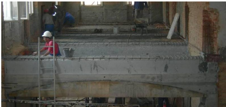
Slika 38: Vgradnja ojačitvenih AB okvirjev (Bergant, 2012)
