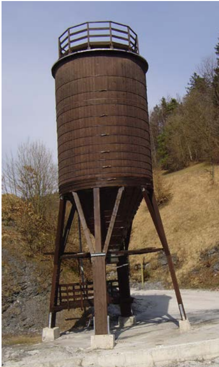
Slika 7: Skladiščenje posipnega materiala v silosu
