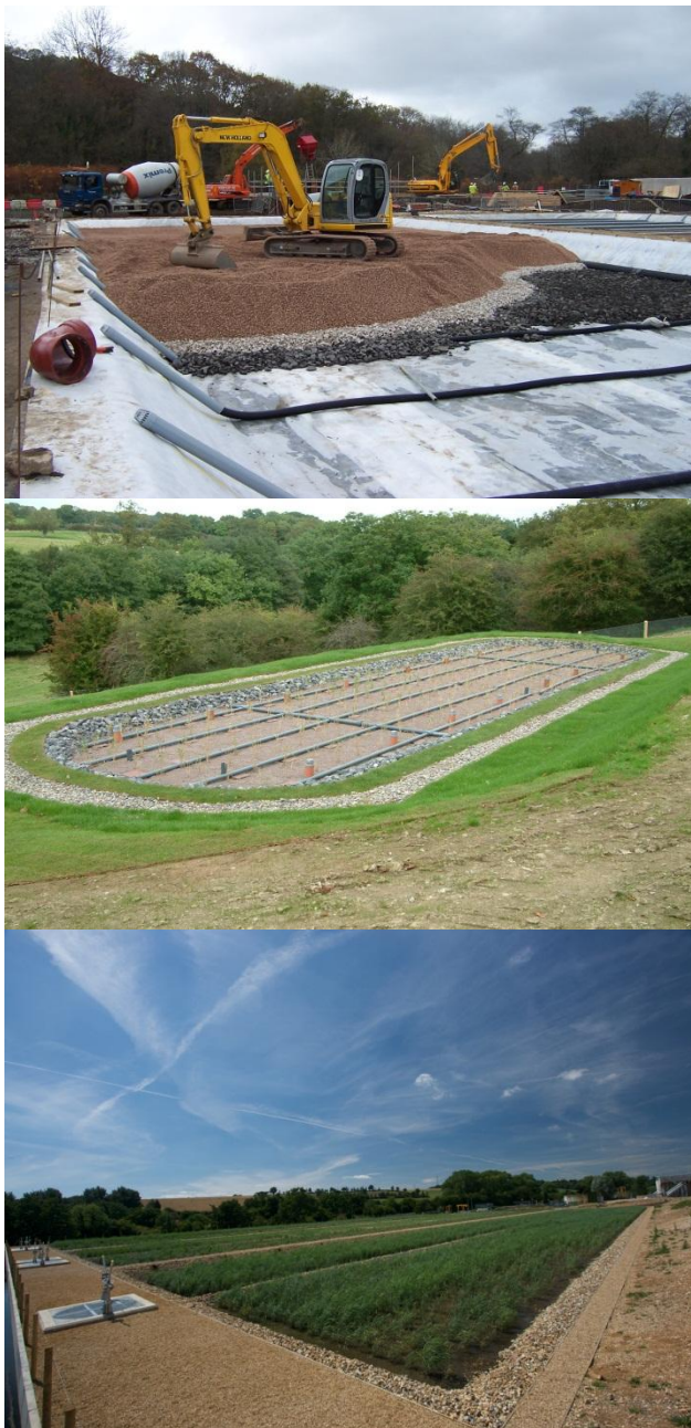
Slika 5: Potek izgradnje rastlinske čistilne naprave ( http://www.constructedwetland.co.uk/gallery/ , 31. 08. 2012)
