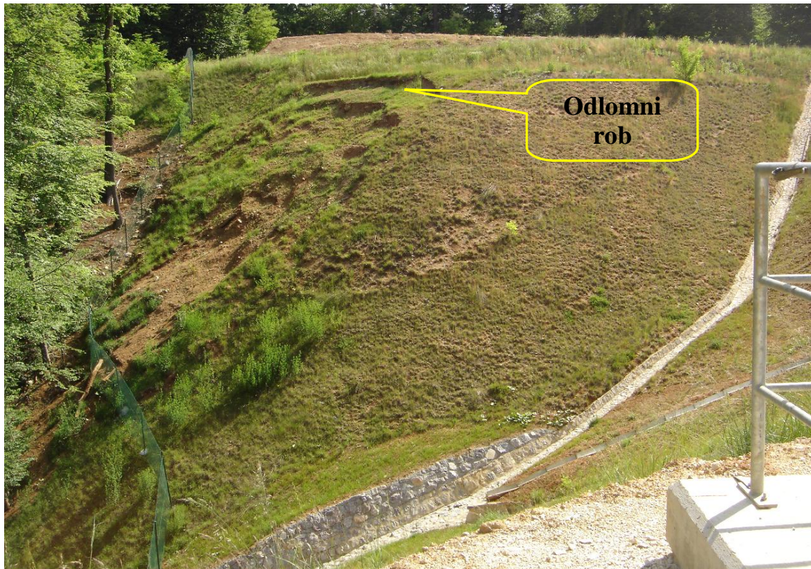
Slika 8: Fotografija brežine pod predvidenim platojem z odlomnim robom.
