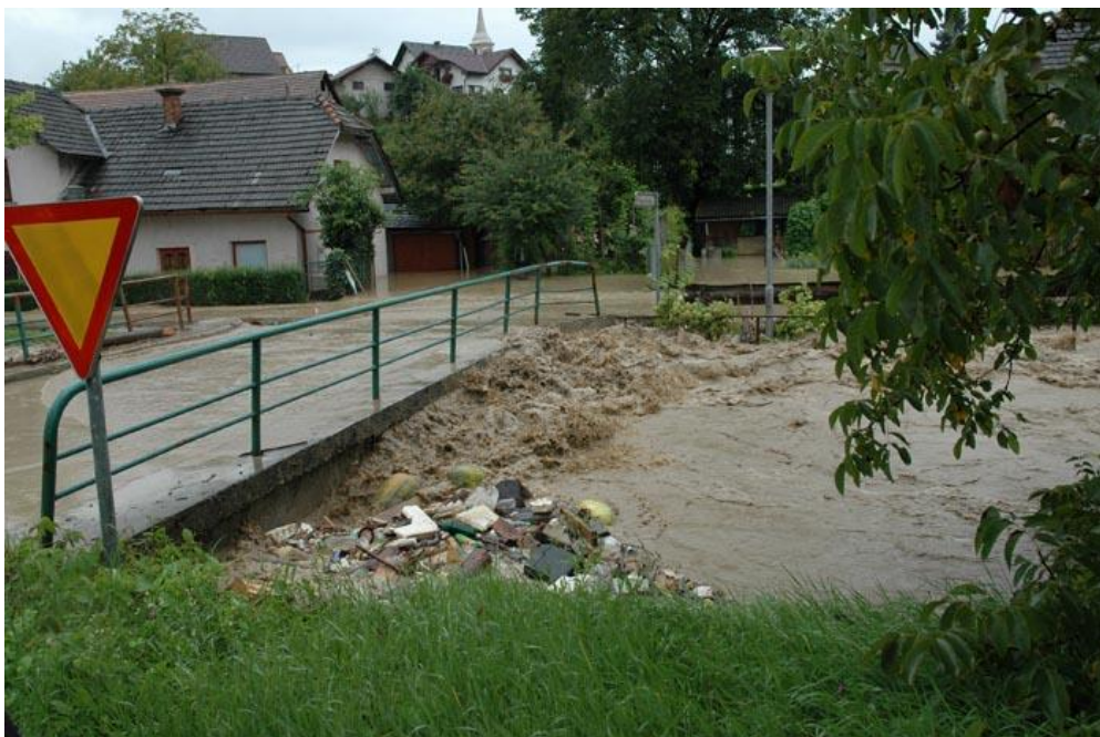
Slika 16: Veliko mostov je bilo poddimenzioniranih
