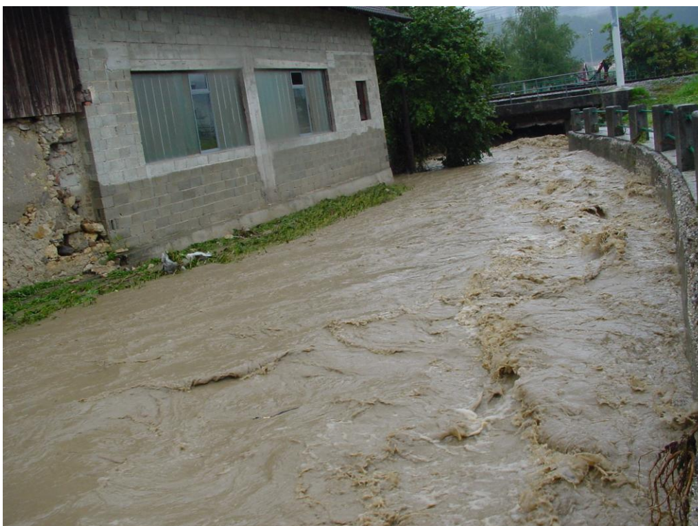
Slika 14: Na gradbenem objektu vidna sled najvišje vode Sevnične v Sevnici dne 21. avgusta 2005 ob 12:38.
