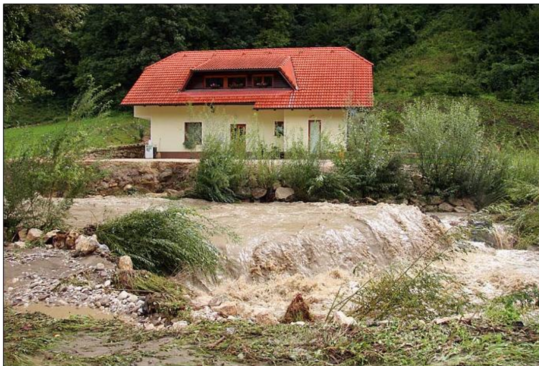
Slika 19: Primer nove gradnje na nevarnem območju, kjer je Sevnična spodjedala bregove
