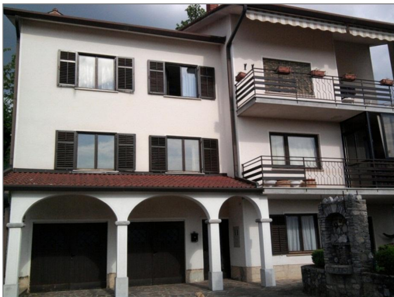
Slika 1: Zahodna fasada obravščane hiše
