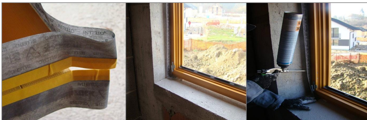
Slika 4: Detajli pri montaži po smernici RAL (vir: [8])
