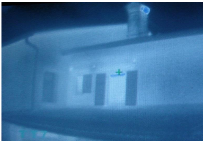
Detajli na vzhodni in severni strani
