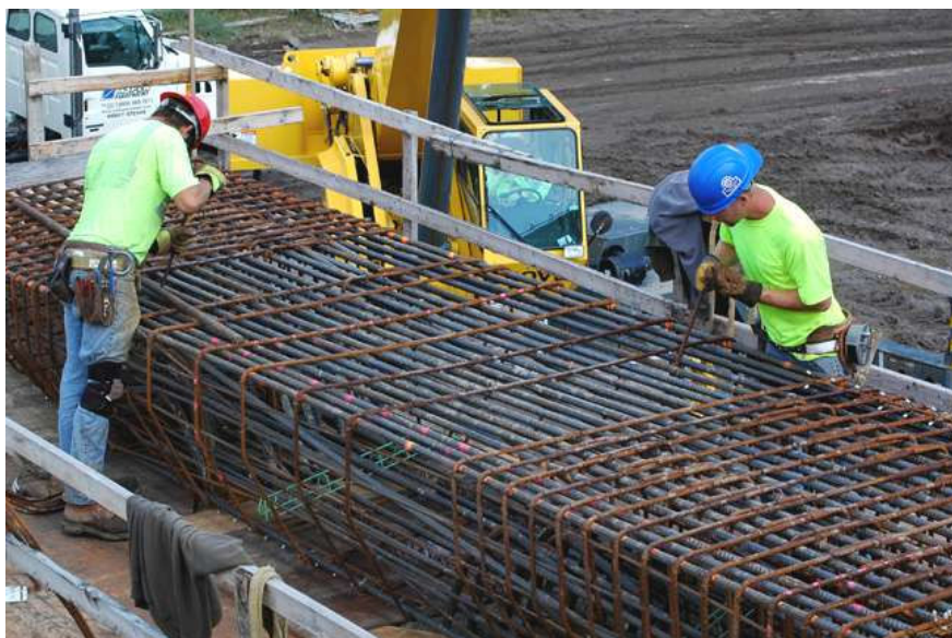
Slika 3: Visoka stopnja armiranja konstrukcijskih elementov (North Dakota State Government, 2012)
