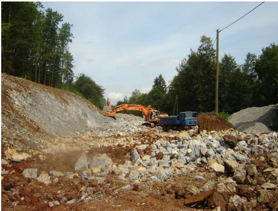
Slika 12: Izvajanje zemeljskih del na trasi železniške proge (foto: Golob)
