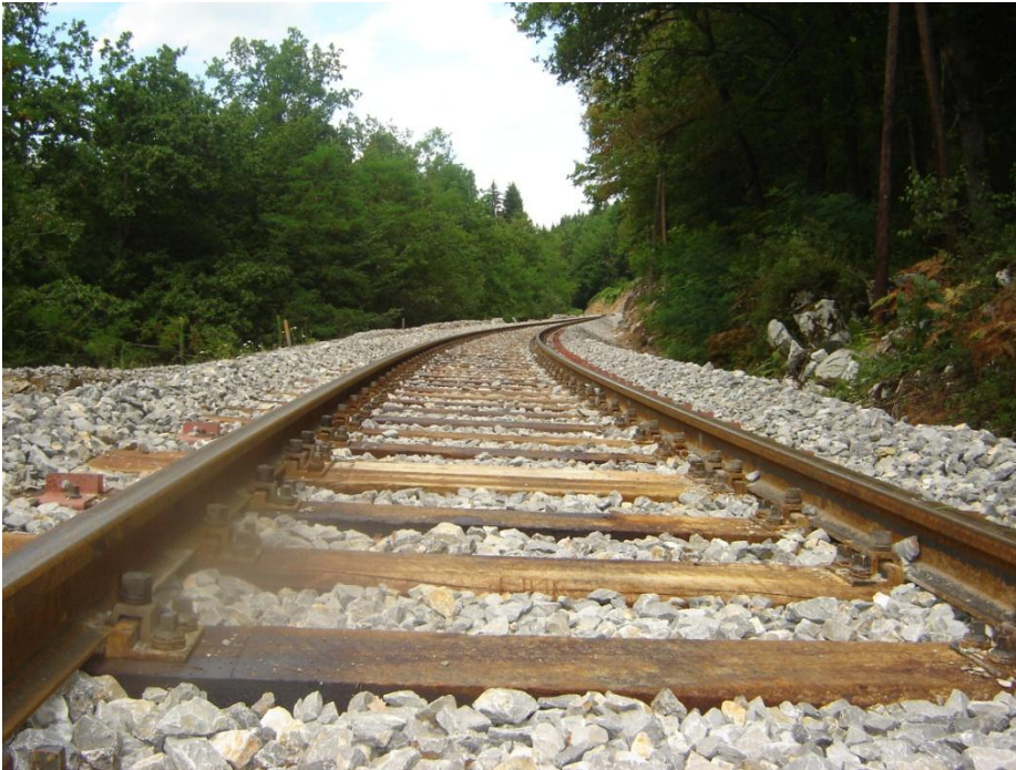
Slika 4: Nadvišanje na zgrajeni železniški progi (foto: Golob)
