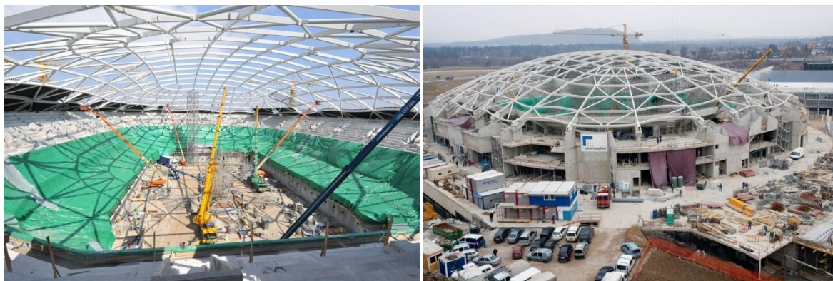
Slika 29: Gradnja strehe športne dvorane, v notranjosti se vidijočasne podpore jeklene strehe
