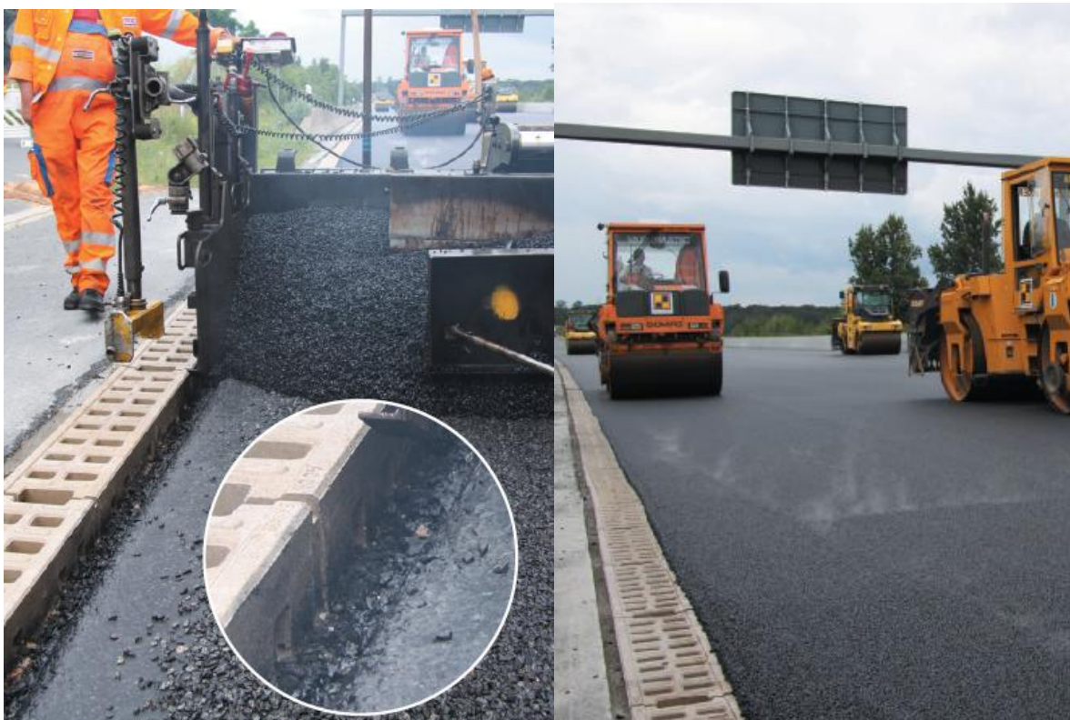
Slika 34: Vgraditev betonskih monoblokov (ACO DRAIN Monoblock, 2009)
