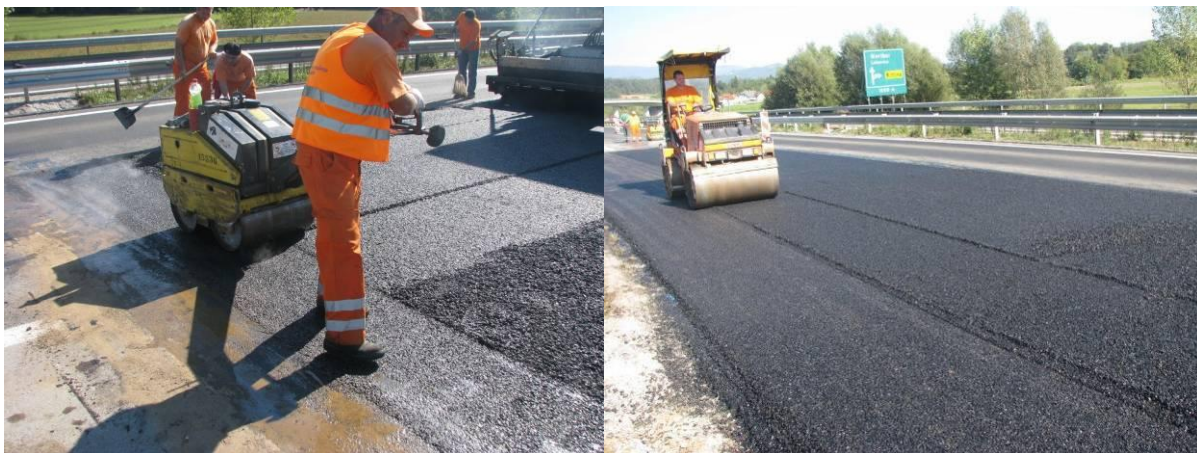
Slika 51: Prikazano kontrolirano zgoščanje PA (lasten vir)
