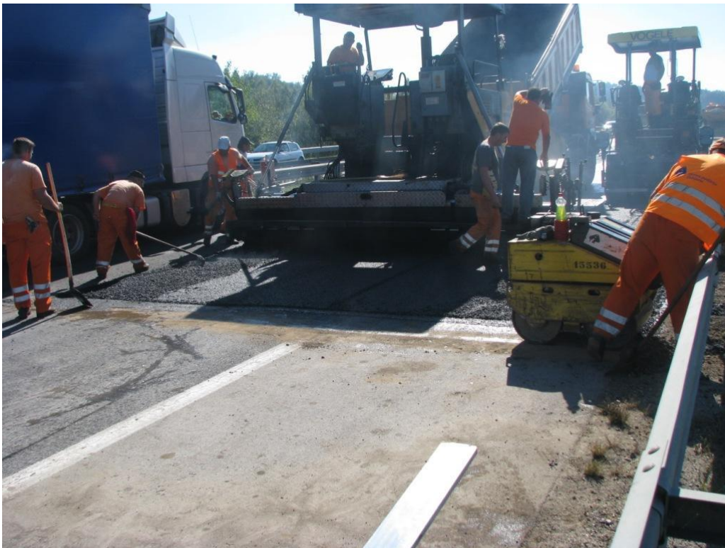
Slika 50: Vgradnja asfaltne zmesi PA z razdelilnikom v območju hladnega stika (lasten vir)
