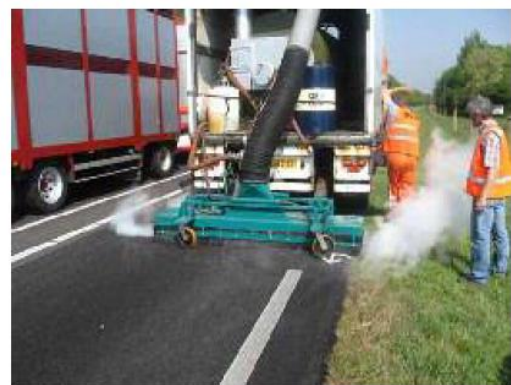
Slika 41: Levo – ultrazvočno čiščenje (prototip), desno – čiščenje s pomočjo pare (Morgan in sod., 2007)
