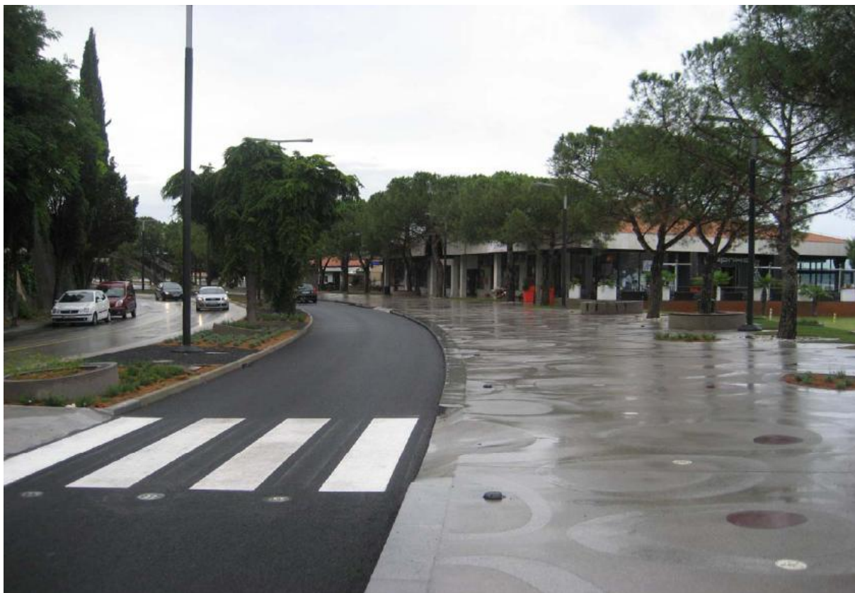
Slika 14: Rekonstrukcija ceste skozi Portorož (Fortuna, 2011)
