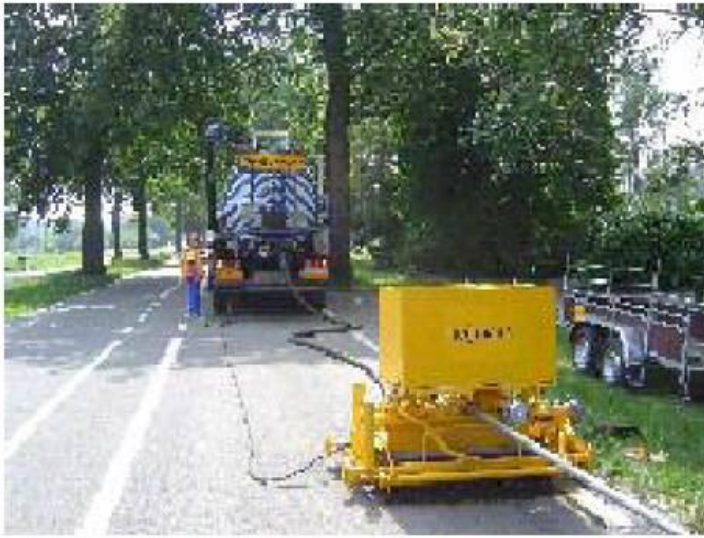
Slika 40: Vakuumsko čiščenje dvoplastnega PA (Morgan in sod., 2007)
