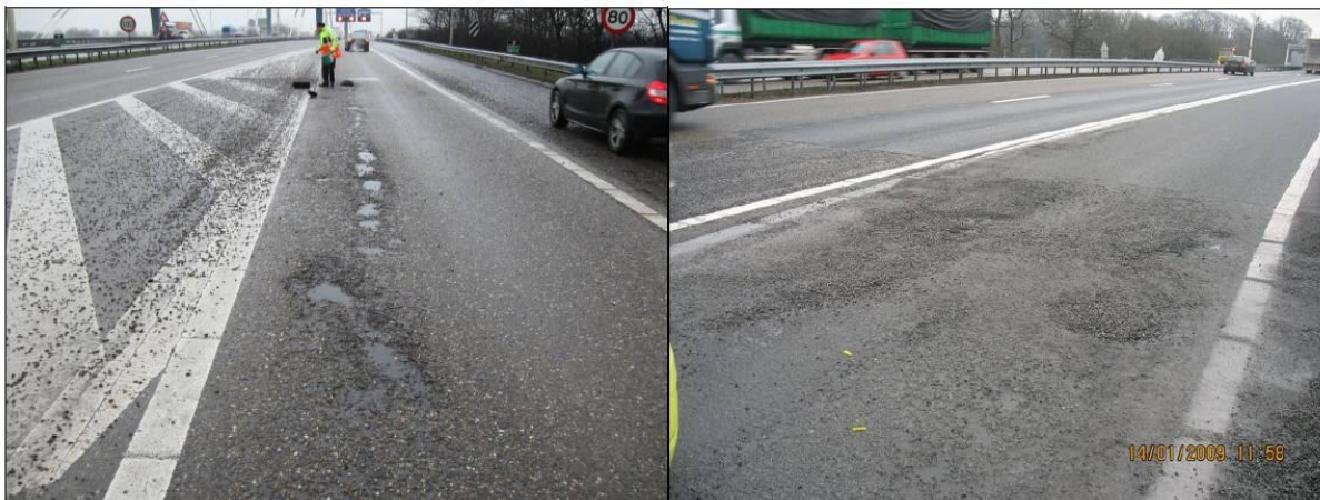
Slika 30: Primer zimskih poškodb - izletavanje zrn (Mohan, 2010)
