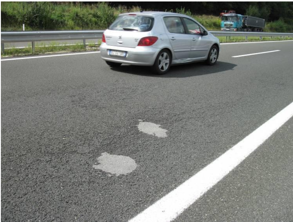
Slika 22: Primer nastanka udarnih jam na drenažni asfaltni plasti (Fortuna, 2011)
