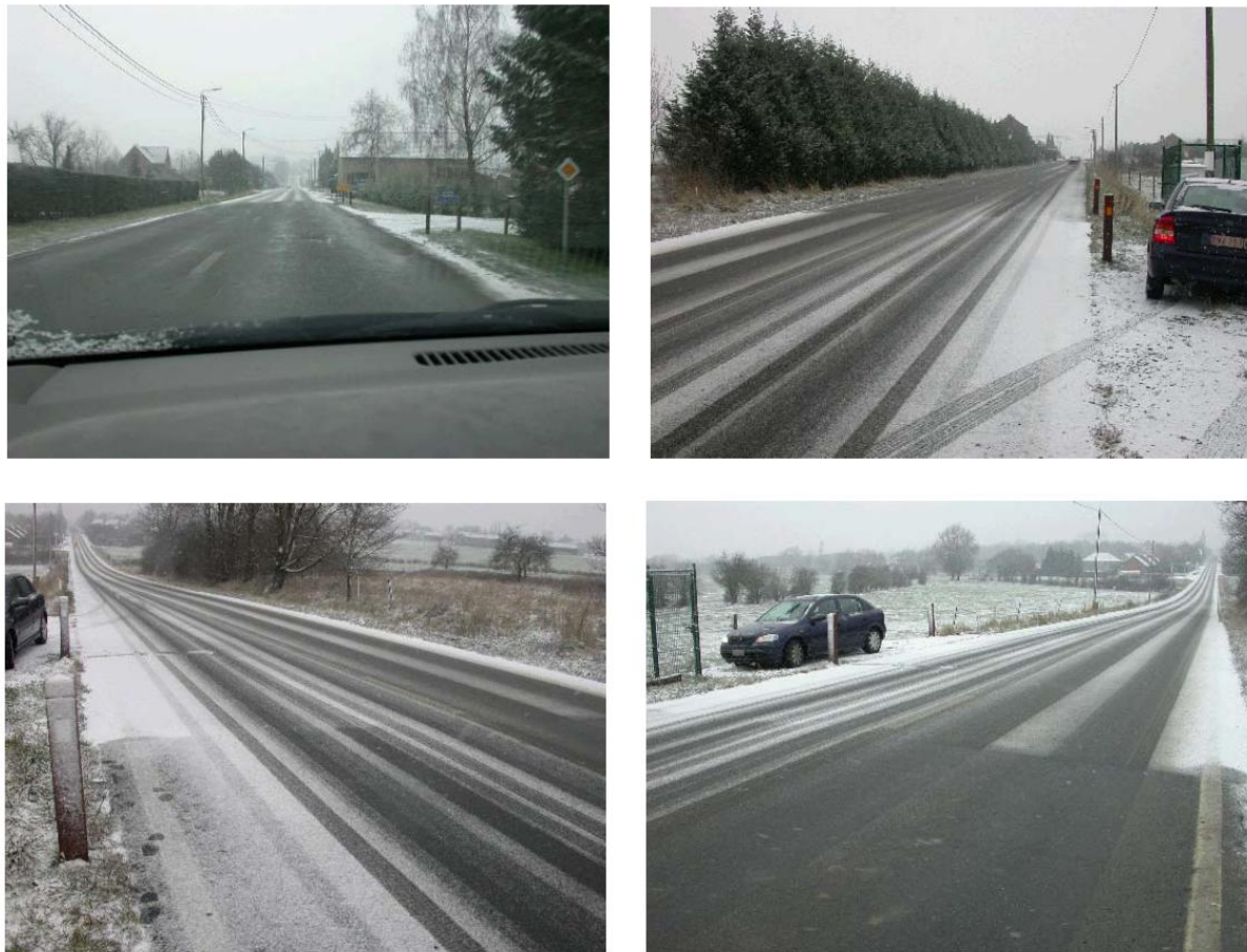
Slika 42: Na podlagi dvoslojnega PA se sneg na začetku sneženja prej oprime cestišča kot v primeru uporabe bitumenskega betona (Cocu, Lefebvre, 2007)
