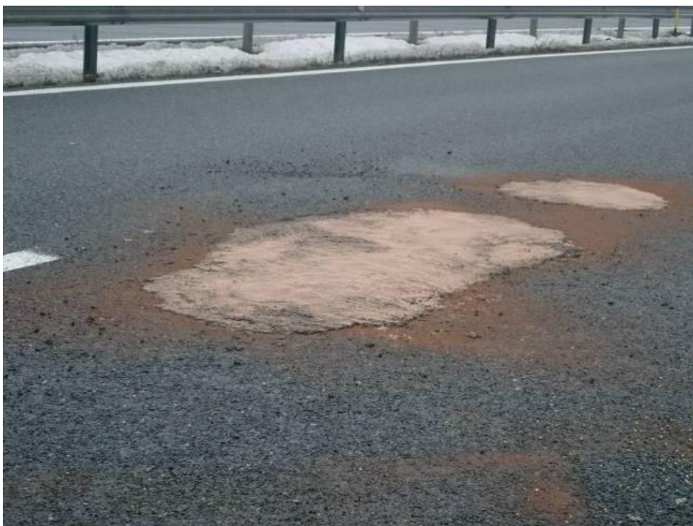
Slika 31: Primer izpada večje površine PA v zimskem obdobju (Fortuna, 2011)
