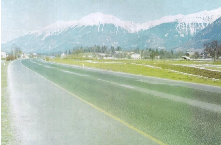
Slika 7: Prva uporaba drenažnega asfalta pri nas na nekdanji gorenjski hitri cesti na odseku Podtabor–Črnivec (Hribar, Žmavc, 2012)
