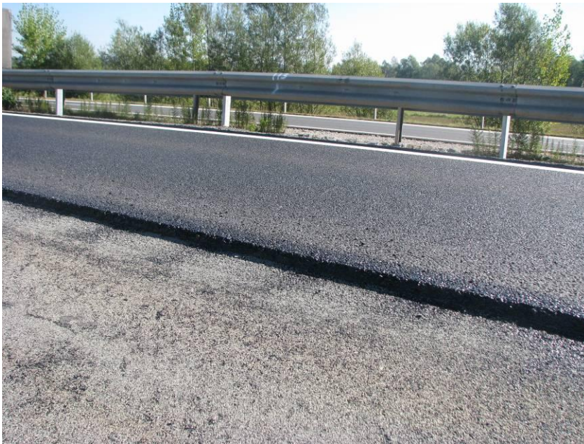
Slika 46: Prikaz vzdolžnega hladnega stika (lasten vir)
