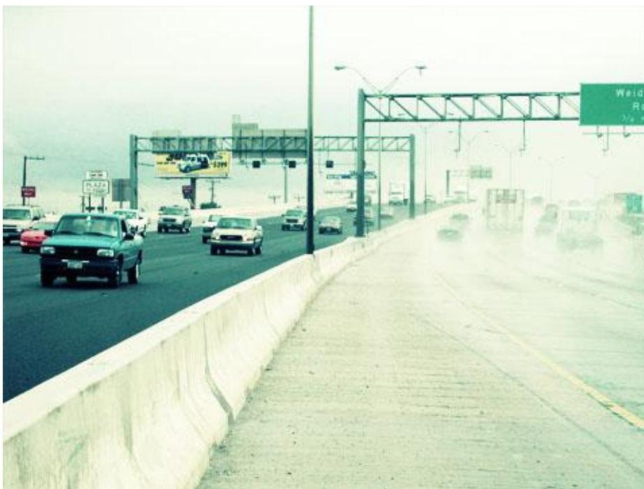
Slika 16: Vožnja po drenažnem asfaltu je zaradi boljše vidljivosti manj stresna (Google, 2012)
