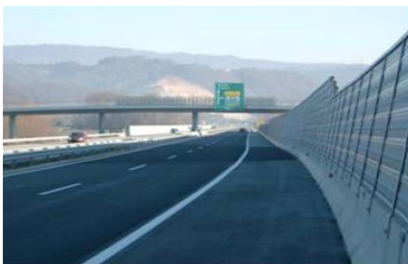
Slika 8: Uporaba PA na vijačenju na odseku AC Grosuplje–Ivančna Gorica (Henigman in sod., 2011)
