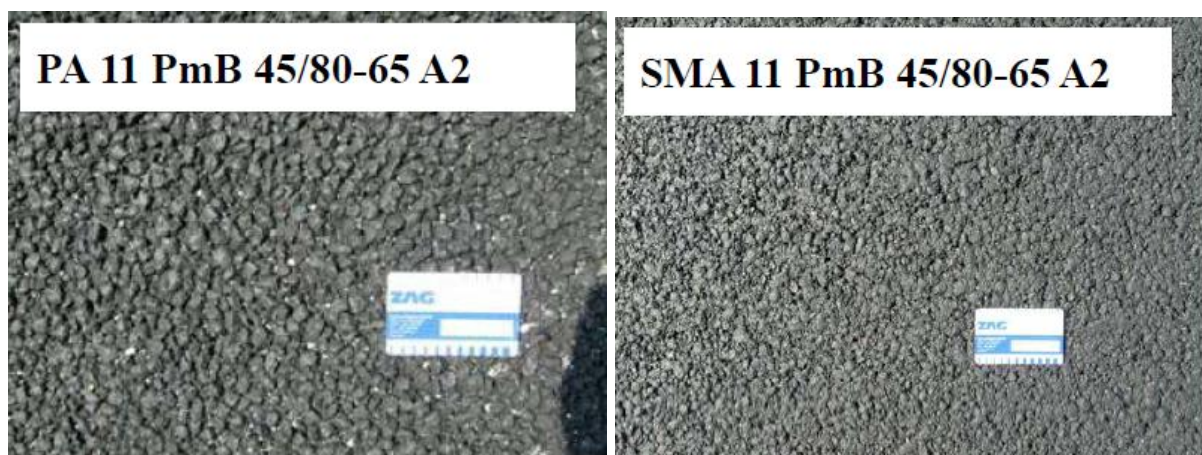
Slika 12: Pogled od zgoraj na različni obrabni plasti: PA (levo) in SMA (desno) (Fortuna, 2011)
