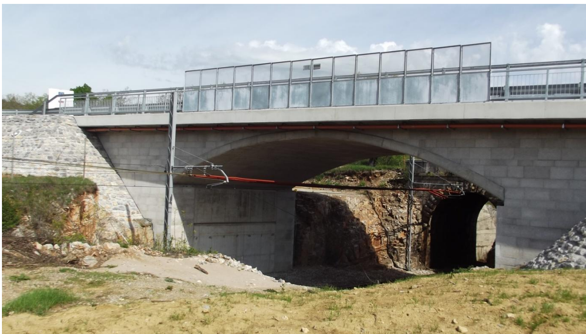
Slika 5: Pogled na novi objekt nadvoza
