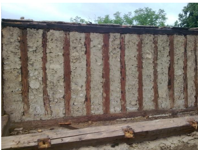
Slika 11: Primer predalčne nosilne konstrukcije hiše na Dolenjskem (foto: Aljaž Sitar).
