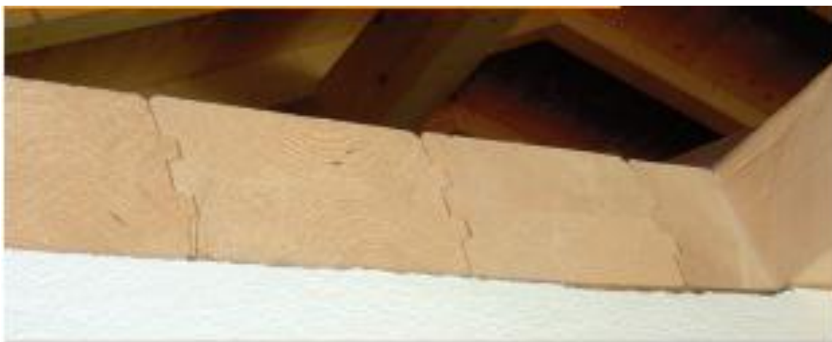
Slika 12: Primer uporabe dvoslojnih nosilcev z utorom in peresom ( www.storaenso.com )
