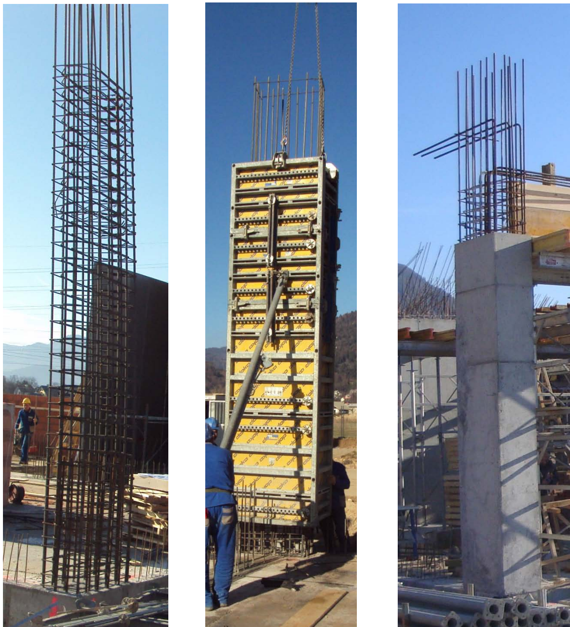
Slika 43: Primer armiranja, opaženja in delno izvedenega stebra (osebni arhiv)
