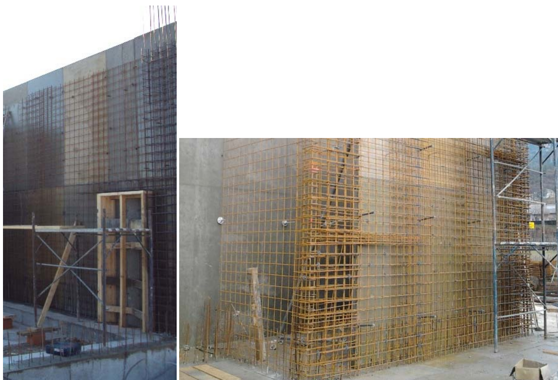
Slika 58: Primer armature v steni (osebni arhiv)
