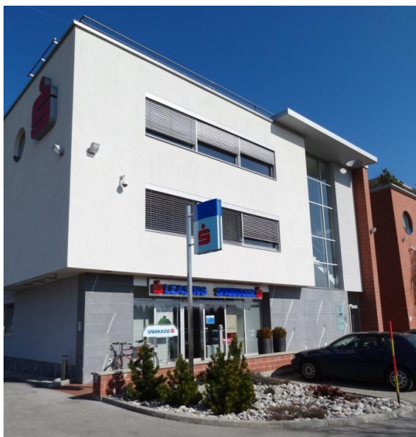
Slika 1: Obravnavan poslovni objekt
