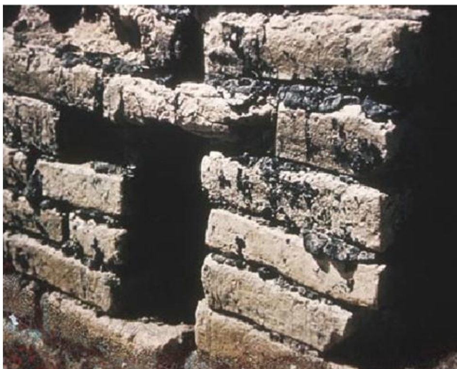
Slika 1: Opečnati zid s katranom kot malto (Vir: http://katachriston.wordpress.com )
