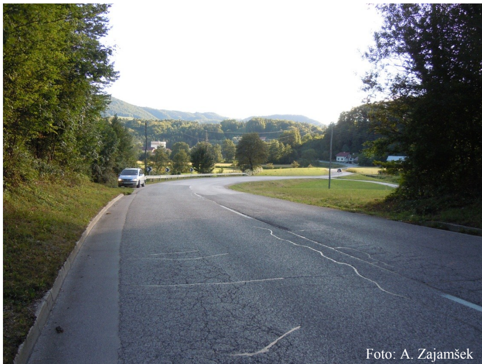
Slika 26: Odsek od 5500 do 5700 – v smeri stacionaže
