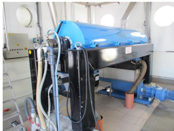
Slika 23: Centrifuga za dehidracijo blata
