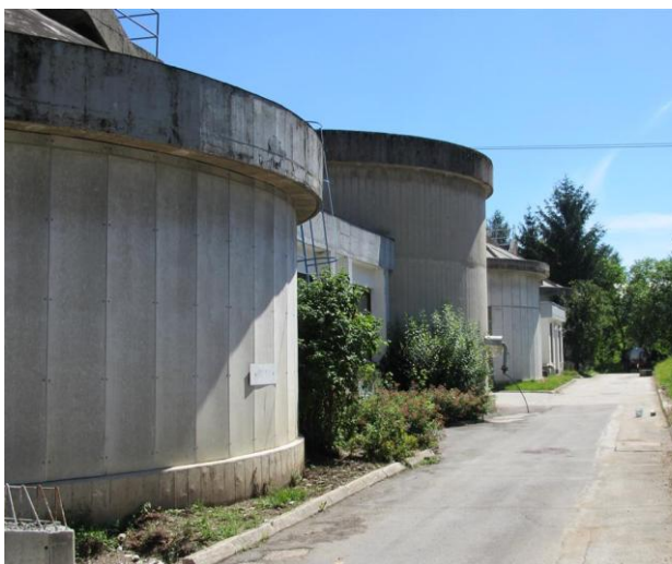
Slika 18: Gnilišča oz. zbiralniki nedehidriranega blata
