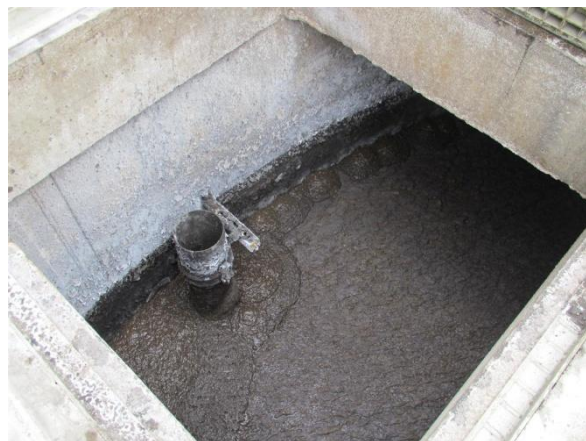
Slika 31: Nedehidrirano blato v notranjosti zalogovnika
