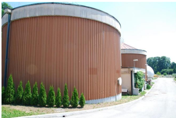
Slika 26: Gnilišča na CČN Kočevje
