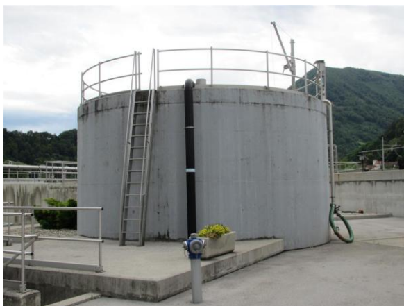
Slika 30: Zalogovnik za nedehidrirano blato na ČN Celje
