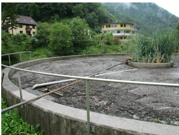
Slika 6: Bazen za nedehidrirano blato na ČN Idrija
