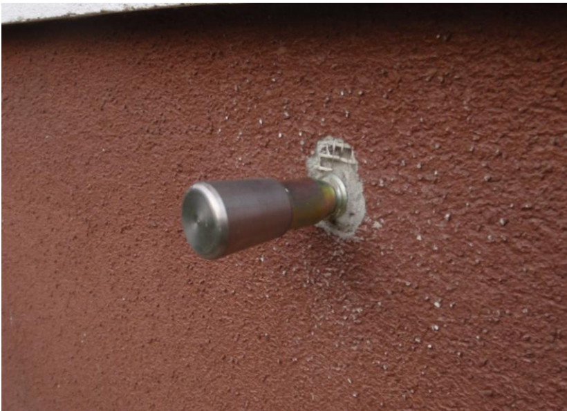
Slika 4: Bližji pogled izhodiščnega reperja R1
