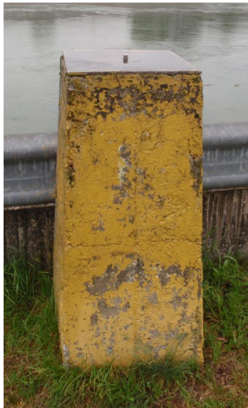
Slika 10: Steber O13 z enolično določenim vrhom vijaka
