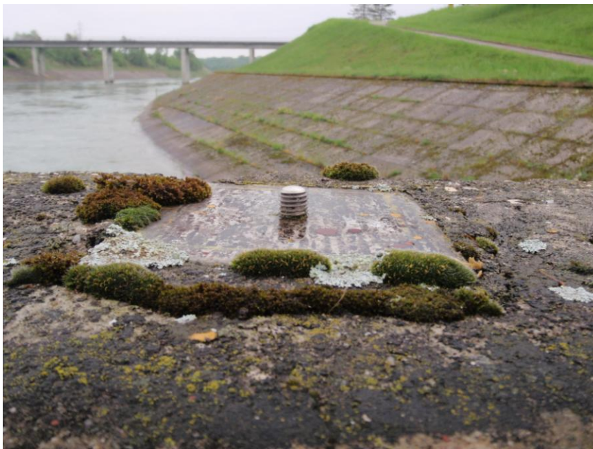
Slika 13: Kontrolna točka H2 na desnem zidu pri iztoku
