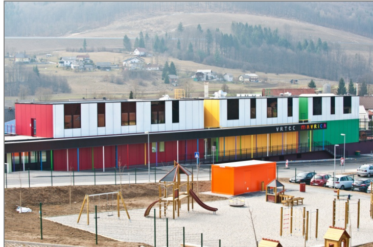
Slika 3: Fasadni sistem Qbiss Air na objektu vrtec Mavrica v Trebnjem
