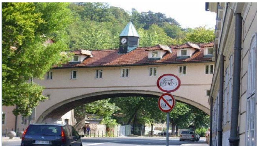
Slika 13: Prikaz stavbe na Karlovški cesti, ki poteka nad voziščem (stavba 364)
