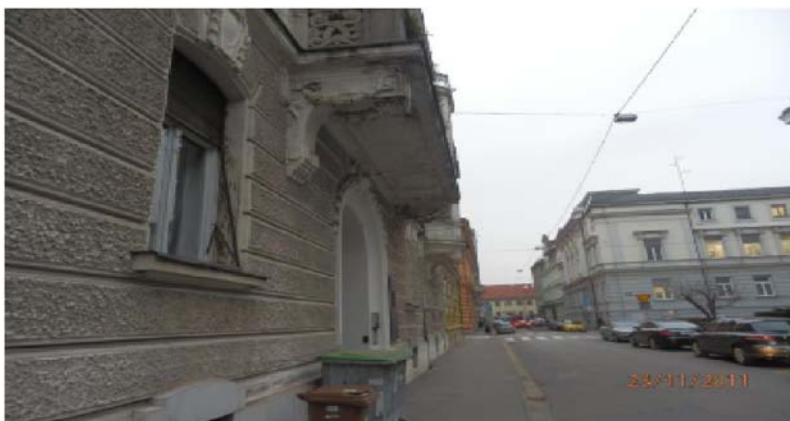
Slika 17: Primer stavbe na Tomšičevi ulici 6 kjer balkon sega na drugo parcelo (Mahne, 2011: 42 str.)
