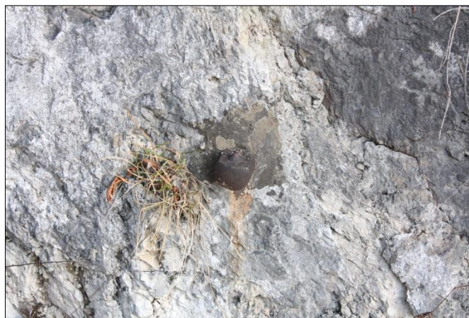
Slika 14: Stabilizacija reperja R21.
