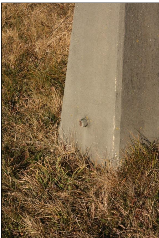
Slika 12: Stabilizacija reperja RXII.
