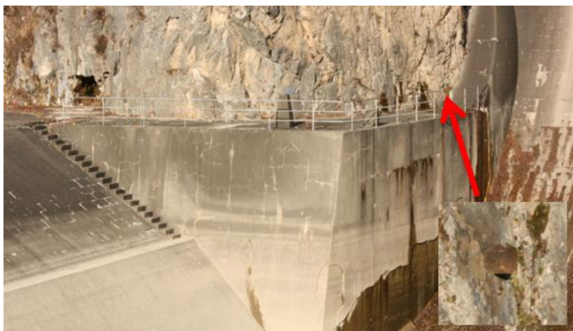
Slika 18: Stabilizacija reperja R23.
