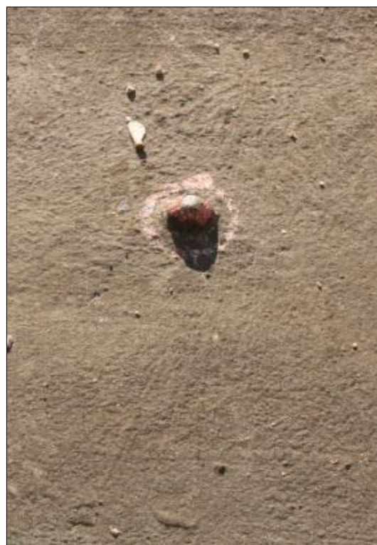
Slika 13: Stabilizacija reperja R29.
