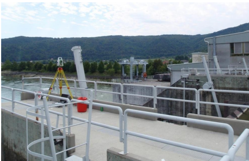
Slika 17: Stabilizacija vezne točke X na pregradi (Kogoj, 2010)
