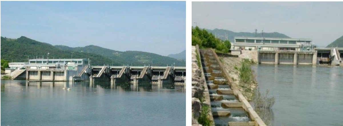
Slika 13: Hidroelektrarna Vrhovo (SEL, 2011, www.sel.si )
