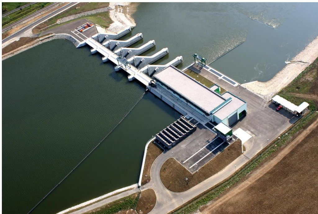
Slika 18: Hidroelektrarna Boštanj (SEL, 2011, www.sel.si )
