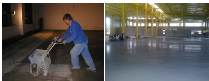
Slika 39: Izvedba nanosa mineralnega posipa (levo) in končan industrijski tlak z mineralnim posipom in dodatno obdelano površino (desno)
