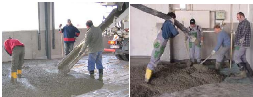
Slika 35: Vgrajevanje mikroarmiranega betona preko drče avtomešalnika (levo) in preko črpalke za beton (desno)
