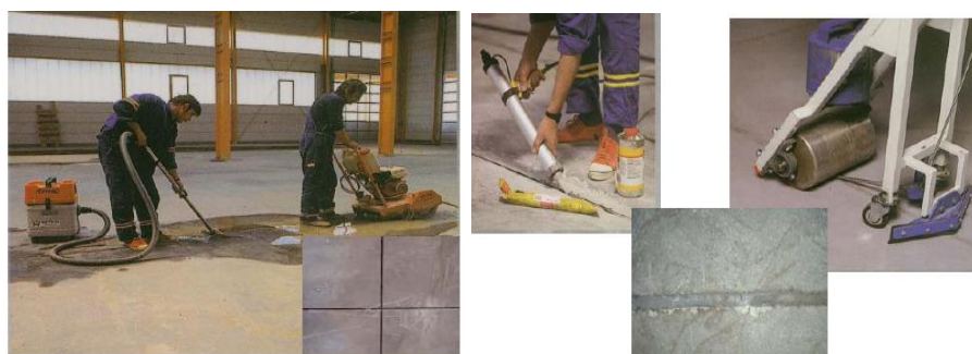
Slika 46: Izvedba rezanja navideznih reg spojnic (levo) in namestitev polnila (desno)
