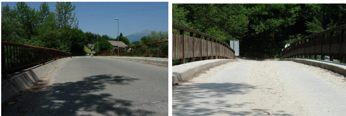
Slika 59: Površina preplastitve mostu čez Kokro pri sotočju z Rupovščico v Kranju (levo) in mostu čez Savo Bohinjko pri Mačkovcu (desno)
