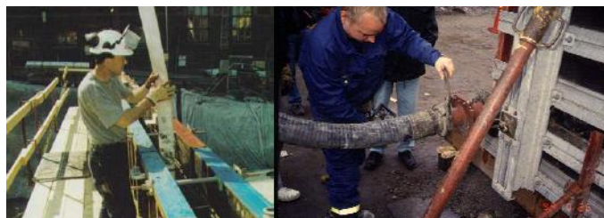
Slika 56: Prikaz vgrajevanja z jeklenimi vlakni mikroarmiranega samozgoščevalnega betona v opaž iz črpalke po metodi gravitacije (levo) in pod pritiskom (desno)
