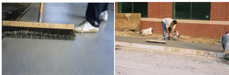
Slika 40: Metličenje mikroarmirane betonske površine
