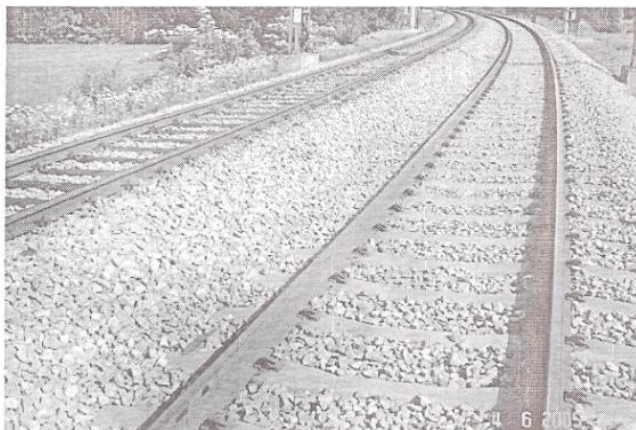
Slika 61: Vgrajeni visokozmogljivi mikroarmirani betonski pragovi na železniški progi Ljubljana–Postojna
