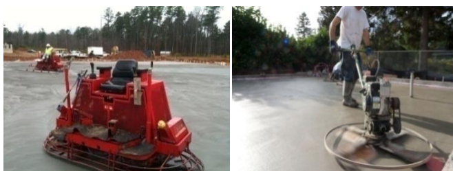
Slika 38: Dve različni izvedbi rotacijskih gladil, imenovanih tudi helikopterji
