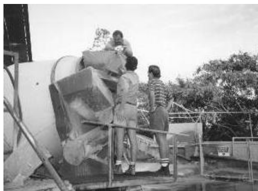
Slika 25: Prikaz ročnega sipanja jeklenih vlaken v boben avtomešalnika
