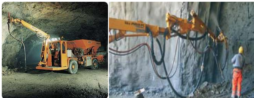
Slika 50: Avtomatiziran sistem za brizganje betona
