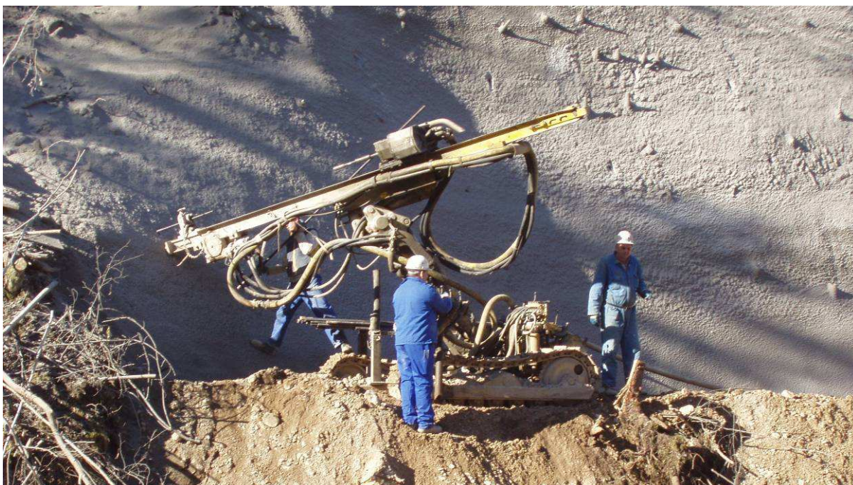
Slika 19: Vrtanje pasivnih sider
