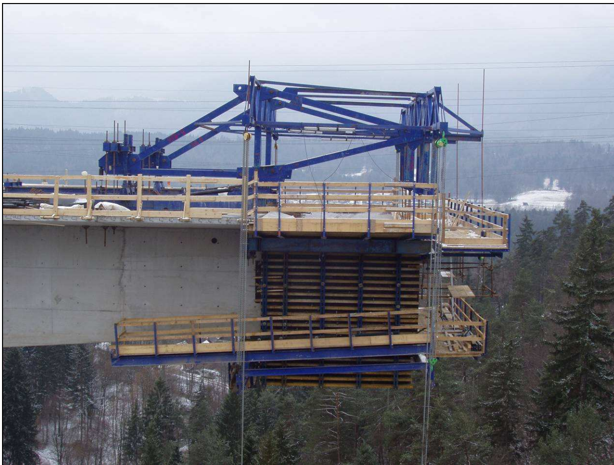
Slika 9: Izvedba prostokonzolne gradnje viadukta Peračica
