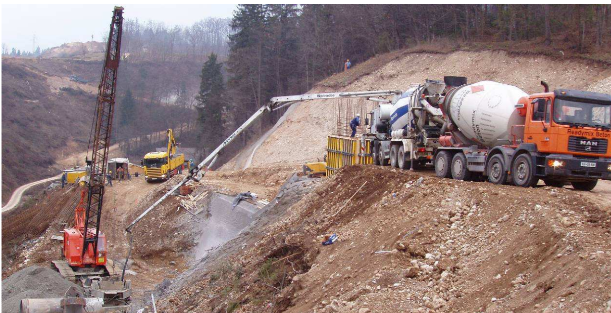
Slika 21: Betoniranje pilota z betonsko avtočrpalko na podpori 6D
