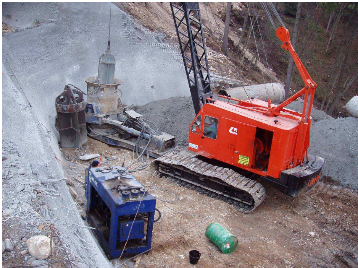
Slika 20: Izkop pilota na podpori 6D
