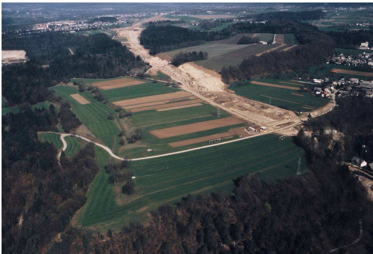
Slika 3: Potek trase AC mimo Radovljice do začetka viadukta Dobruša
