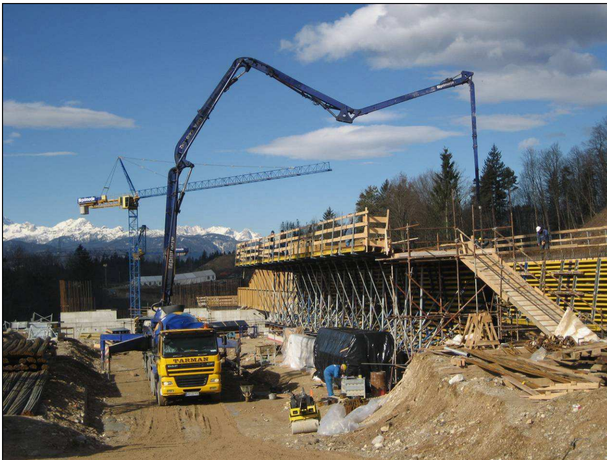
Slika 27: Delavnica za narivanje zgornje konstrukcije, betoniranje prvega takta levega objekta
