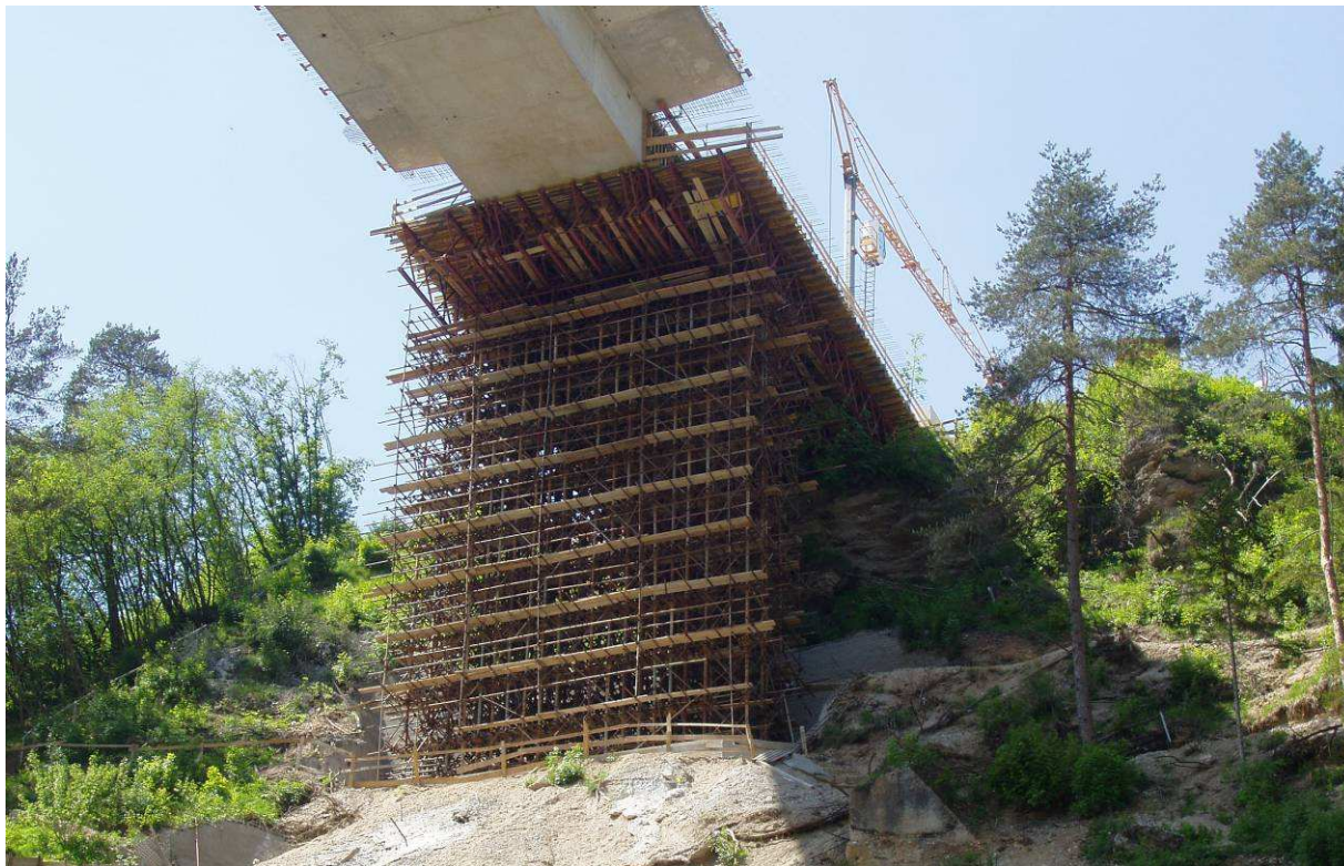
Slika 31: Izvedba začasne podpore na viaduktu Peračica
