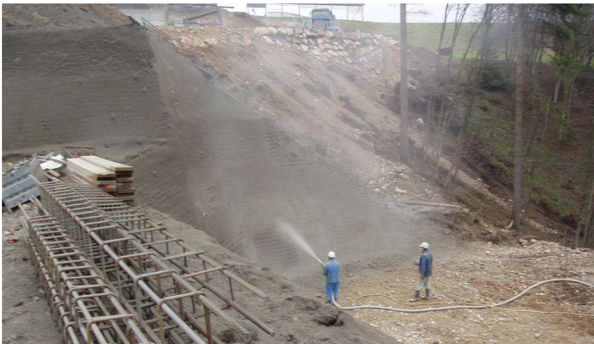
Slika 18: Izvedba torkretnega obrizga na podpori 6D
