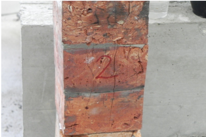
Slika 33: Porušitev opečne prizme P2
