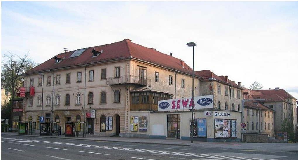
Slika 1: Severna in zahodna fasada Kolizeja – pogled iz Gosposvedske ulice (Žiga, 2006)
