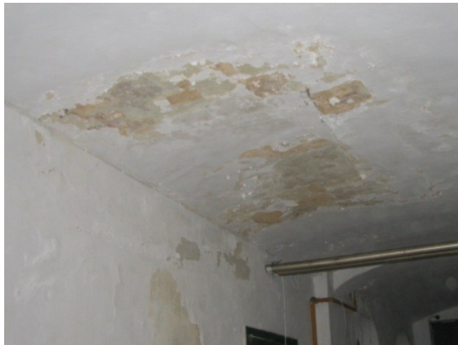
Slika 5: Cvetenje in izločanje soli iz vgrajenih materialov
