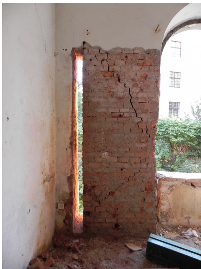
Slika 46: Zid v pritličju po končanem testu
