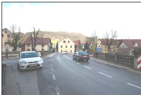
Slika 25: Obnovljeni most preko reke Drete.
