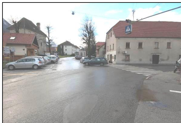
Slika 24: Priključna cesta (križišče) v center naselja.
