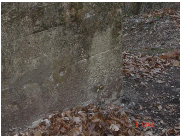
Slika 5.4: Novo stabiliziran reper RK454
