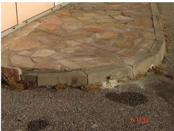
Slika 5.3: Novo stabiliziran reper RK3
