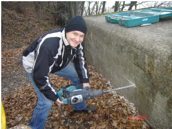
Slika 5.5: Vrtanje luknje za stabilizacijo novega reperja
