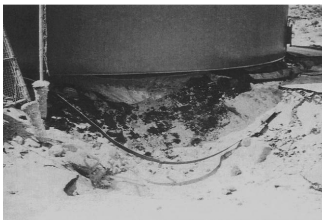
Slika 5: Porušitev na mestu stikovanja lupine in dna
