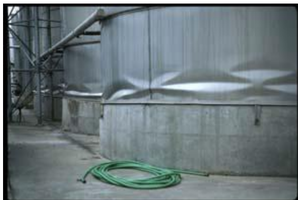
Slika 25: Izbočenje diamantne oblike (»diamond shape buckling«)
