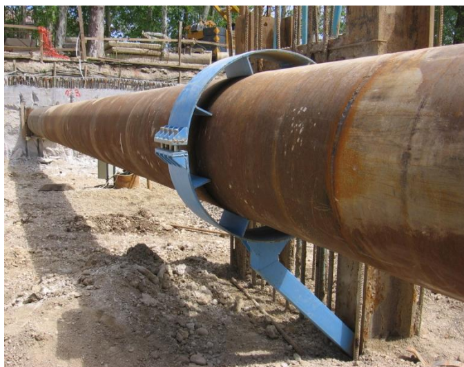
Slika 41: Detajl razpore in spojnice pri stebri (foto: Jerič, 2010)
