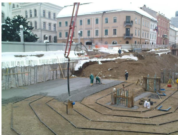
Slika 29: Vgrajevanje podložnega betona (foto: Jerič, 2010)
