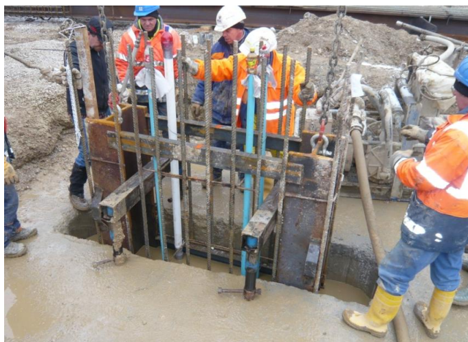
Slika 23: Namestitev armaturnega koša za steber (Swietelsky, 2010)
