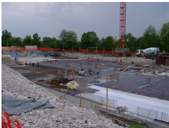
Slika 2: Gradbena jama s prostimi brežinami (foto: Jerič, 2008)
