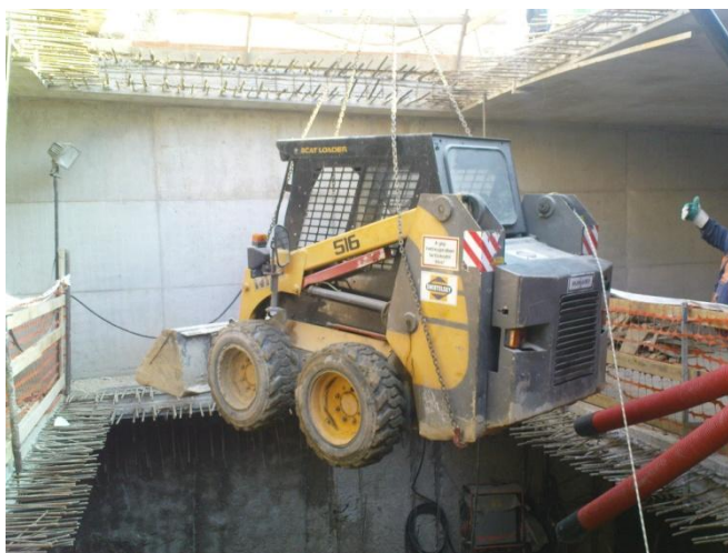
Slika 33: Dvigovanje gradbenega stroja (foto: Jerič, 2010)
