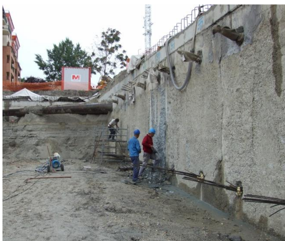
Slika 4: Armirano betonska diafragma (Swietelsky, 2007)
