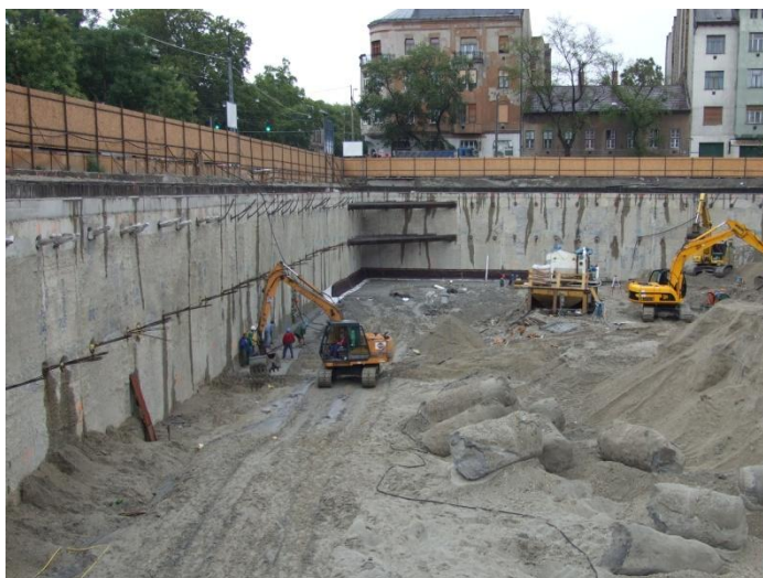
Slika 3: Gradbena jama z oporno konstrukcijo (Swietelsky, 2007)
