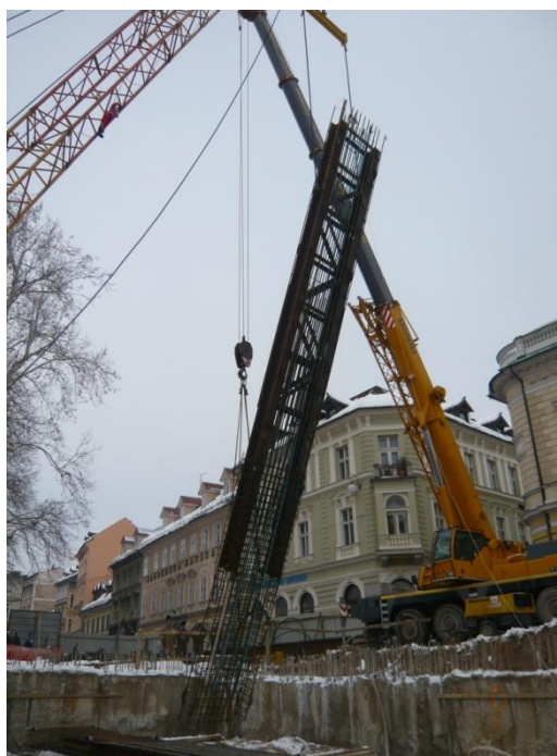
Slika 19: Montaža armaturnega koša (Swietelsky, 2010)
