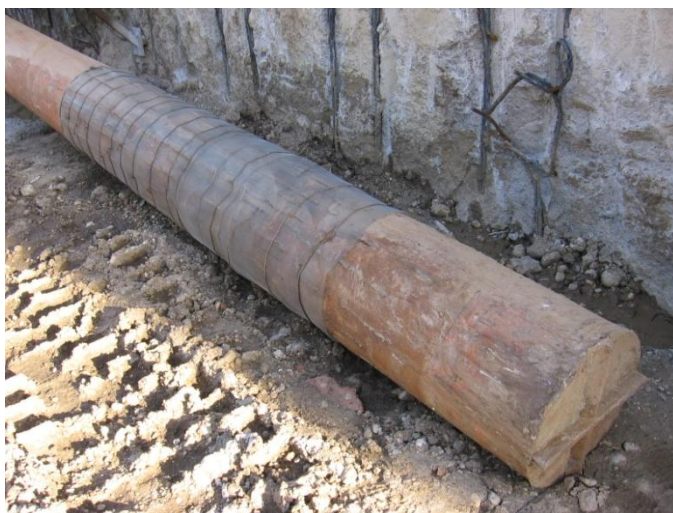
Slika 25: Spodnji perforirani del vodnjaka (foto: Jerič, 2010)
