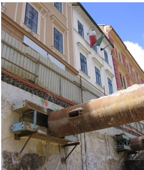
Slika 42: Konzola za obešanje jeklene razpore (foto: Jerič, 2010)
