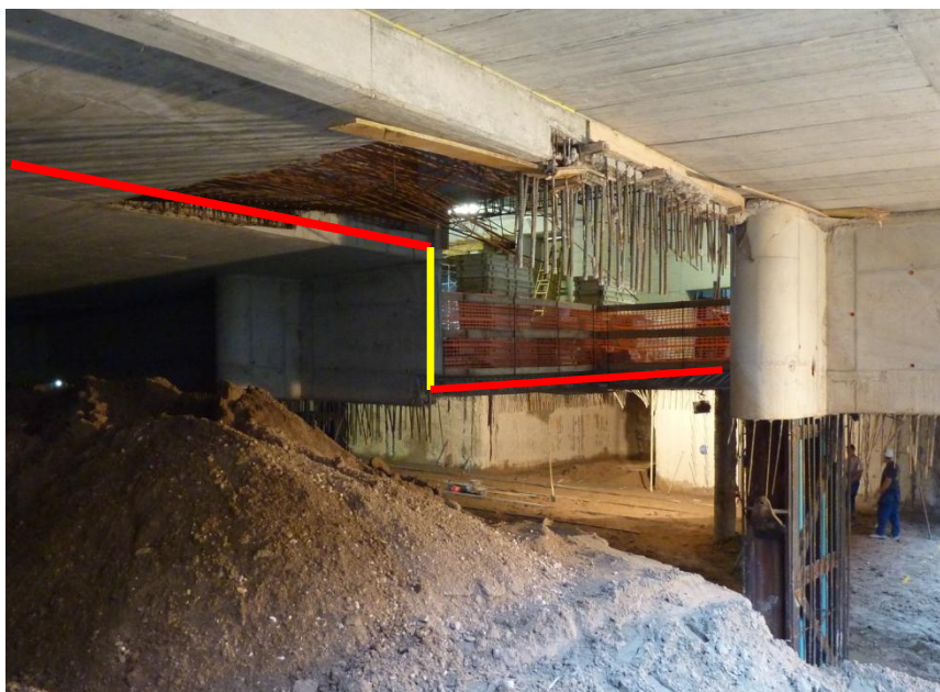
Slika 21: Medetažna razporna plošča in stena (foto: Jerič, 2010)
