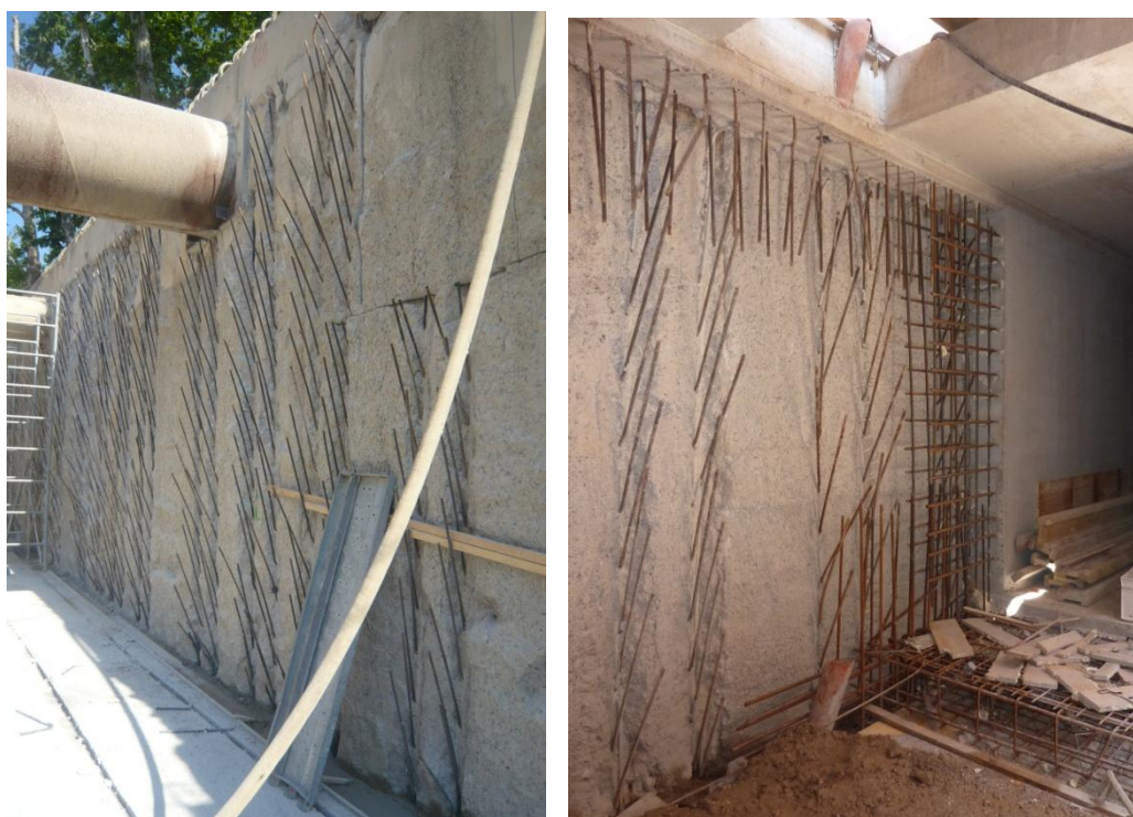
Slika 20: Povezovalne armaturne palice v AB diafragmi (foto: Jerič, 2010)
