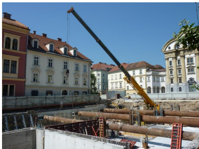
Slika 43: Demontaža razpore (foto: Jerič, 2010)
