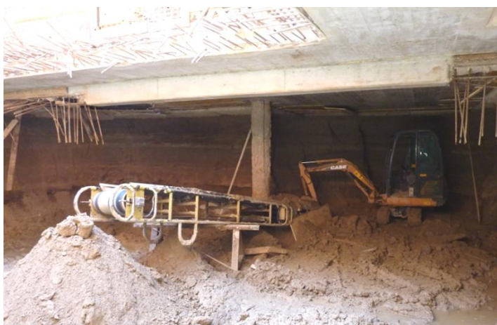
Slika 35: Trakovi za transport izkopane zemljine (foto: Jerič, 2010)
