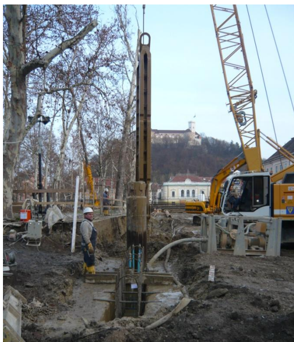
Slika 18: Vodilni kanal diafragme (Swietelsky, 2009)
