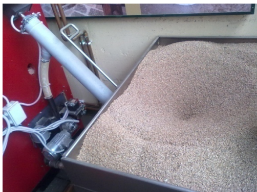
Slika 41: Peč z dozirnikom za koščice v oljarni Hrvatin (Oljarna Hrvatin, 2012)
