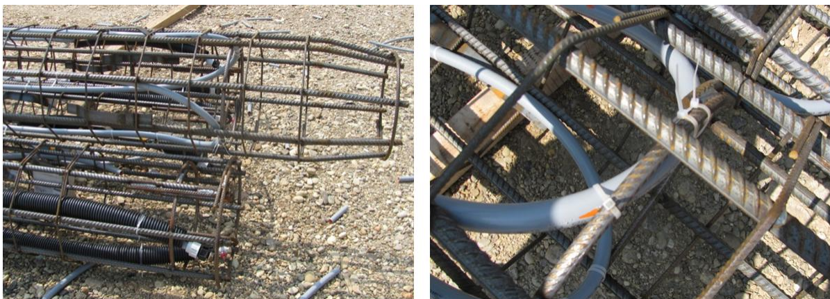
Slika 8: Pritrjevanje zank absorpcijskih cevi je izvedeno s plastičnimi sponami ter se konča pol metra pred koncem armaturnega koša
