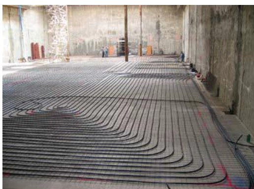
Slika (privzeta) 20: Razporeditev absorpcijskih cevi v energetski temeljni plošči – primer 2 (Adam et al., 2011)
