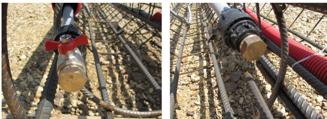
Slika 9: Spojni kroglično-navojni ventil (levo) z metuljčkom in (levo in desno) varovalno pokrivno matico
