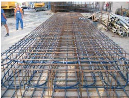
Slika (privzeta) 18: Armaturni koš z absorpcijskimi cevmi za izdelavo energetske diafragme (Adam, 2010)
