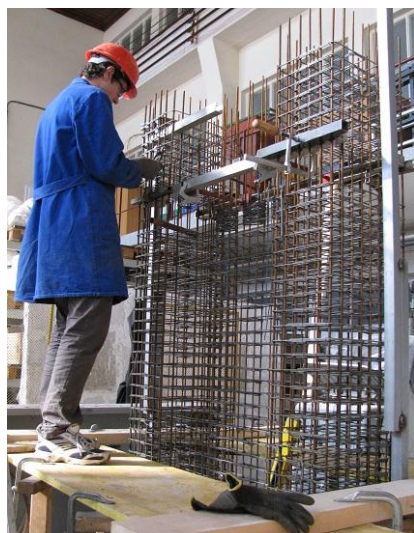
Slika C.4: Izdelava armaturnega koša stebra
