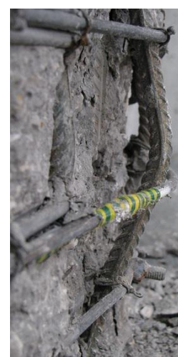
Slika C.12: Uklon palic vzdolžne armature
