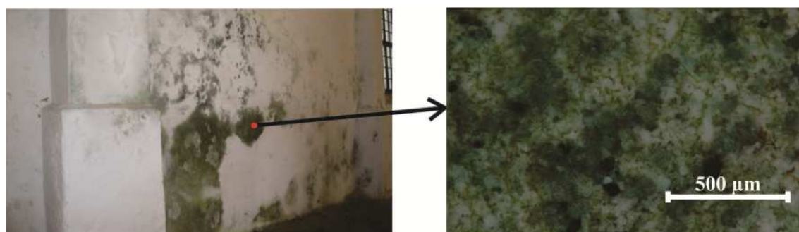
Slika 20: Slika biodegradacije pri 200x povečavi
