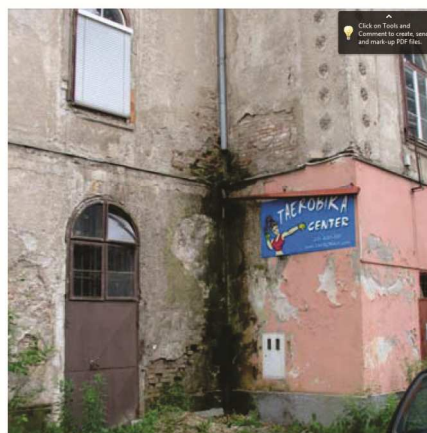
d) Biodegradacija in odpadanje ometa
