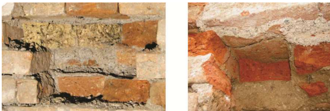
Slika 37: Uporaba različnih vrst opeke (levo) in uporaba različnih vrst malt (desno) (Kržan, 2008: str. 20)
