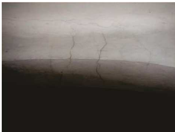
Slika 38: Razpoke na loku zaradi preobremenitev (Kržan, 2008: str. 14)
