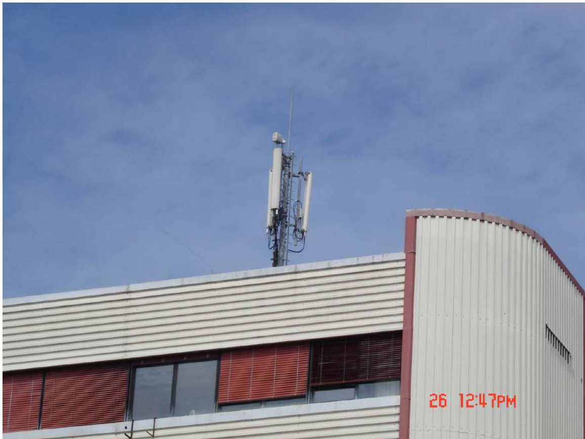
Slika 3: Antene na zgradbi poslovnega prostora
