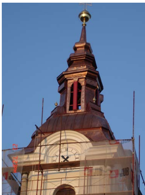
Slika 1: Antena na cerkvenem zvoniku
