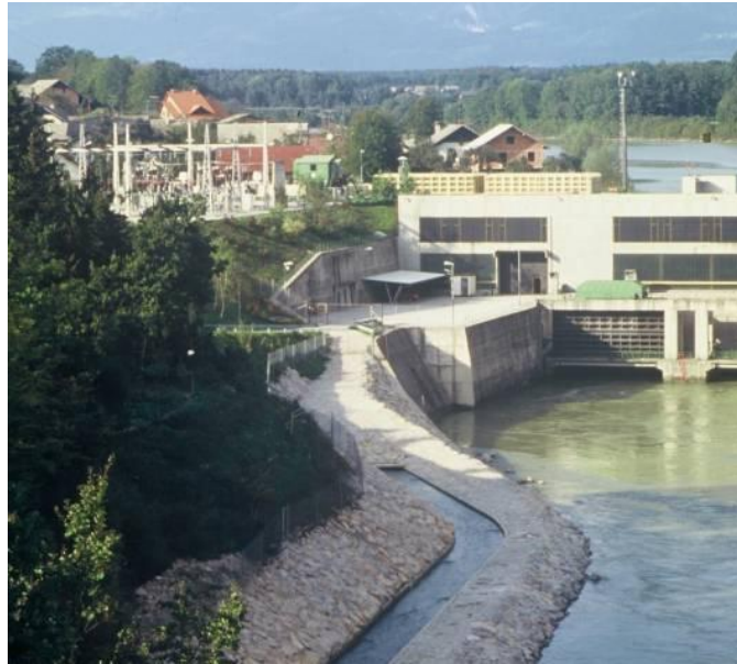
Slika 15: HPP Mavčiče – drstišče. Figure 15: HPP Mavčiče – spawning area.
