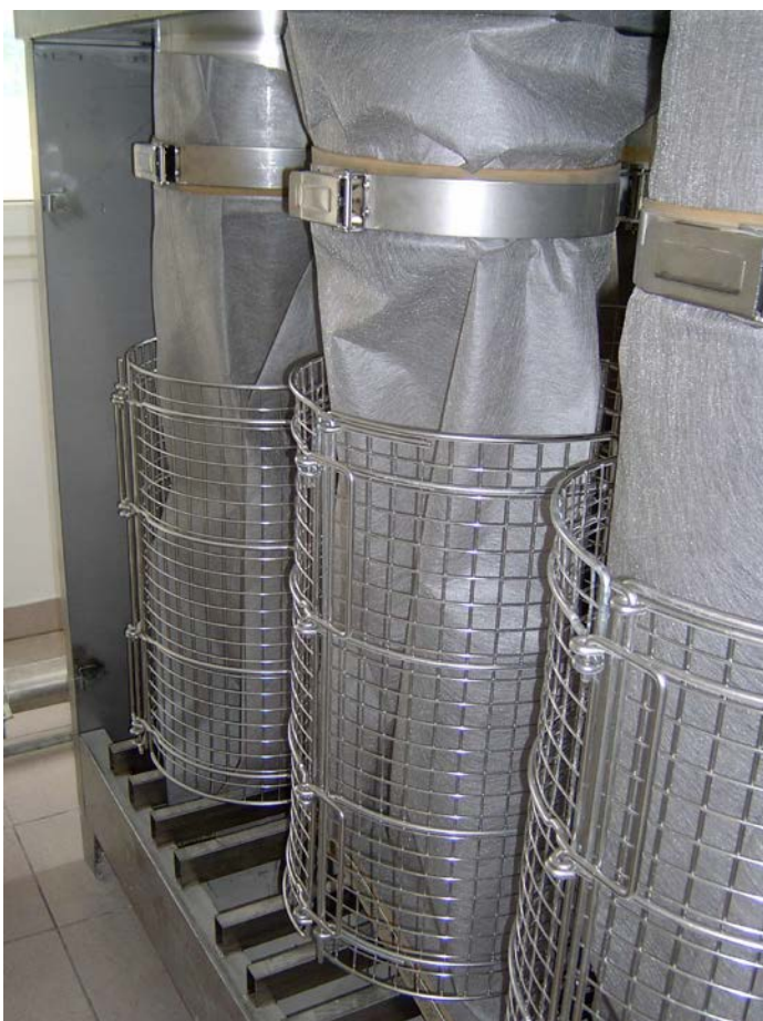
Slika 41: Vreče za skladiščenje blata (ČN Kostanjevica)
