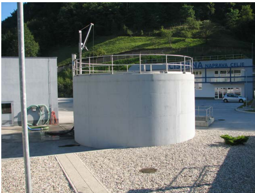
Slika 24: Zalogovnik, ki služi za skladiščenje blata (ČN Celje)
