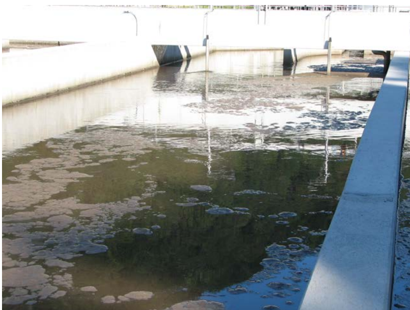
Slika 21: Paralelni (aerobni) bazen (ČN Celje)
