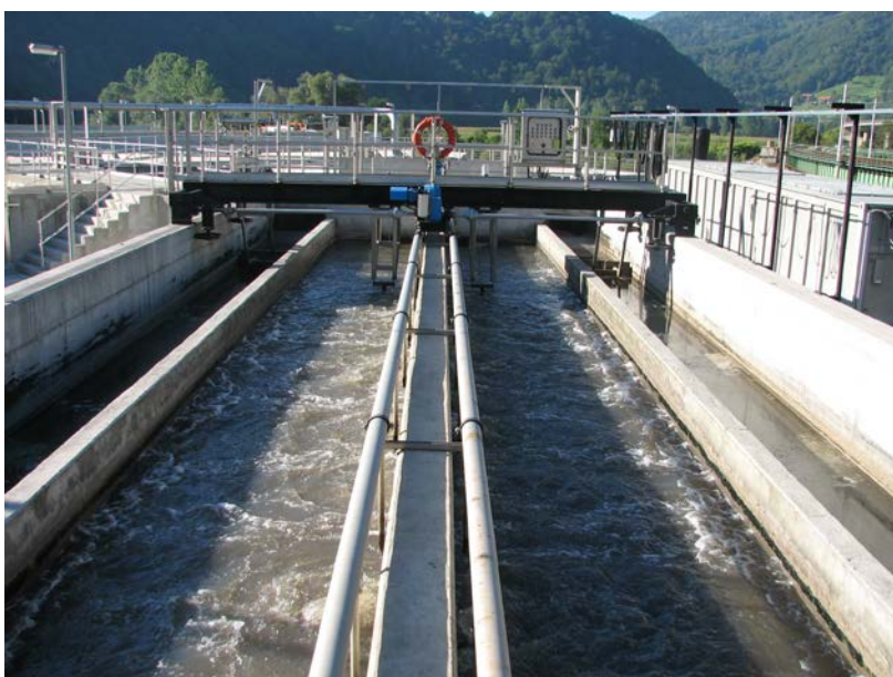
Slika 19: Ozračen peskolov in maščobnik z mostnim strgalom (ČN Celje)
