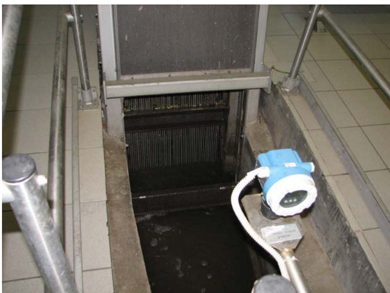
Slika 18: Elektromotorne verižne grablje (ČN Celje)
