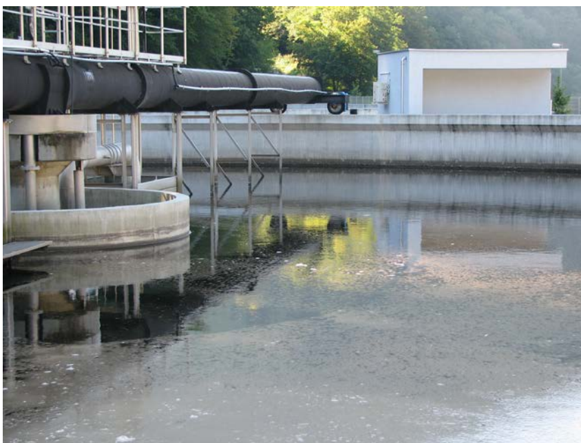
Slika 22: Naknadni usedalnik v katerem se aktivno blato gravitacijsko ločuje od očiščene odpadne vode (ČN Celje)
