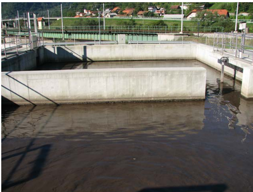
Slika 20: Paralelna anaerobna bazena s potopnimi mešali (ČN Celje)
