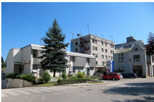
g1) Stavba Policijske uprave Krško
