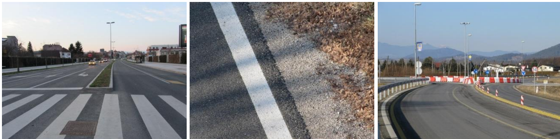
Slika 3: Primeri elementov za zagotavljanje večje varnosti cest
