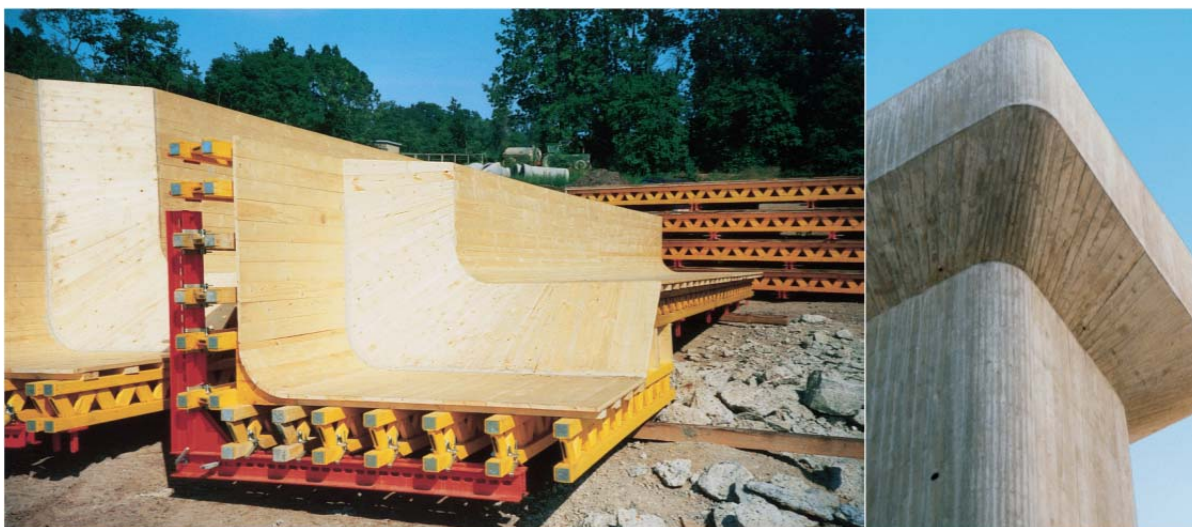
Slika 2: Uporaba žaganega lesa pri vidnem betonu (Fairfaced Concrete, 2002, str. 1)
