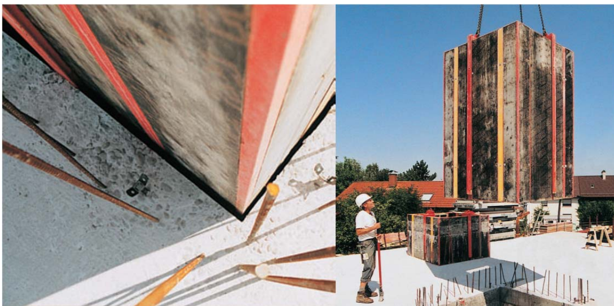
Slika 15: Uporaba jaškovnega elementa TRIO (TRIO, 2011, str. 29)
