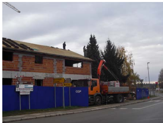
Slika 78: Prikaz postavitve avtodvigala (foto: Konda, 2011)
