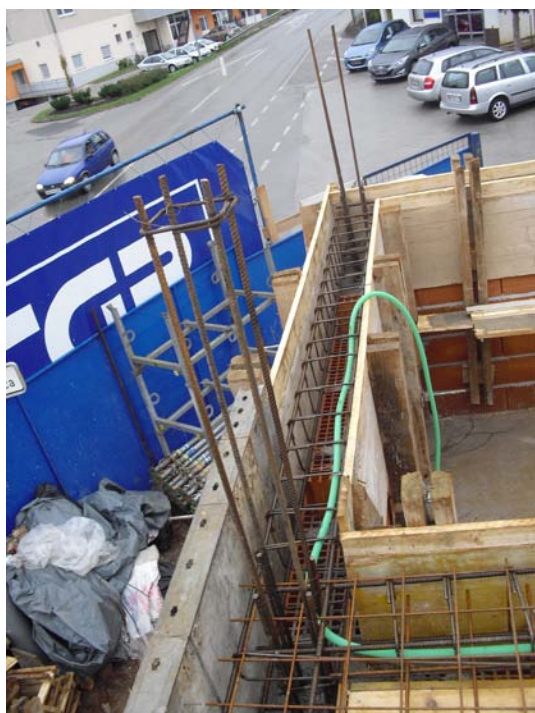
Slika 21: Armatura v vencu plošče (foto: Konda, 2011)
