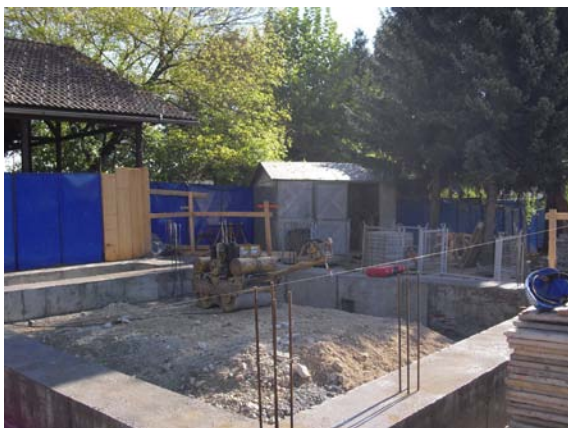
Slika 57: Utrjevanje nasipa med temelji (foto: Konda, 2011)
