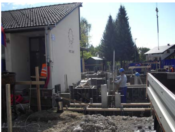
Slika 49: Prenos višin za temelje z nivelirjem (foto: Konda, 2011)
