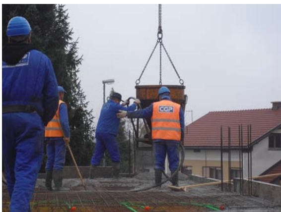
Slika 67: Transportna posoda z betonom za betoniranje plošče (foto: Konda, 2011)
