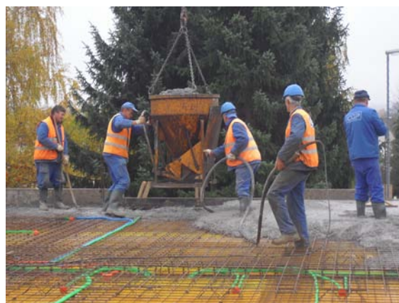
Slika 26: Praznitev transportne posode z betonom (foto: Konda, 2011)
