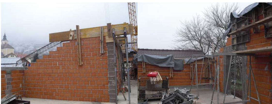
Slika 39: Opaž horizontalnih vezi nadstropja (foto: Konda, 2011)
