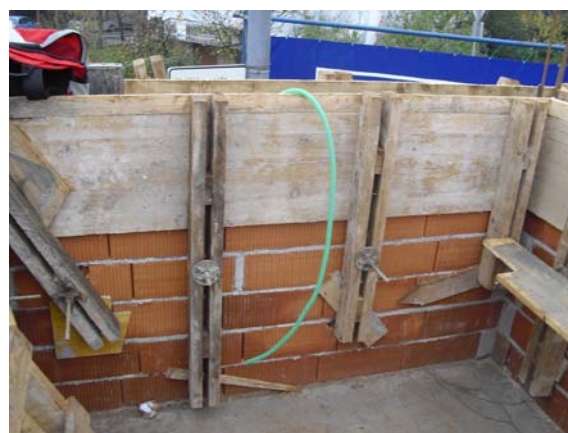
Slika 36: Opaž venca na stopnišču (foto: Konda, 2011)
