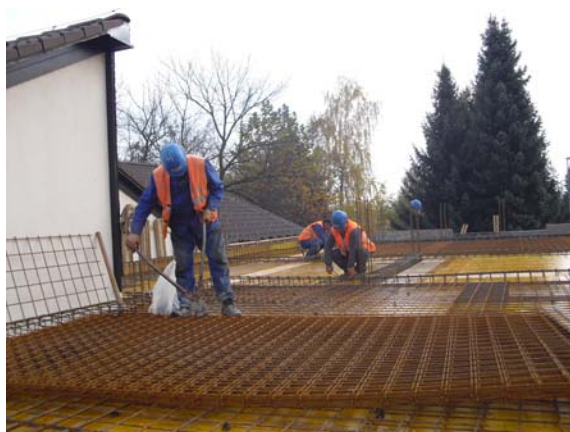
Slika 23: Polaganje armature na plošči (foto: Konda, 2011)
