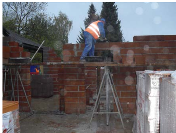
Slika 31: Zidanje na višini, uporaba pomožnega odra (foto: Konda, 2011)
