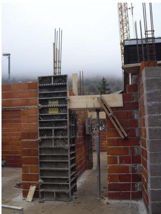
Slika 33: Opaž preklade nad vrati (foto: Konda, 2011)
