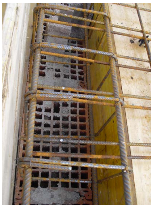
Slika 22: Detajl armature v vencu plošče (foto: Konda, 2011)
