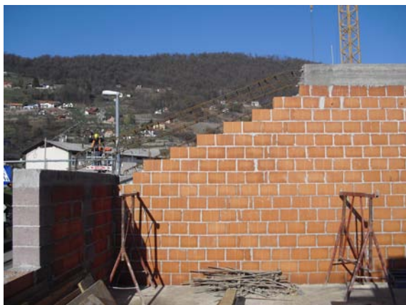
Slika 73: Armatura poševnih vezi nadstropja in horizontalna vez nadstropja (foto: Konda, 2011)
