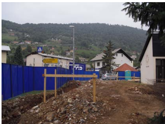
Slika 10: Prikaz zakoličbe nove trase vodovoda (foto: Konda, 2011)
