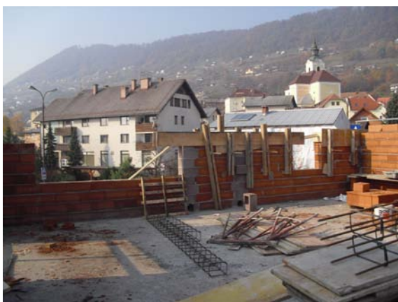
Slika 37: Opaž vezi kolenčnega zidu (foto: Konda, 2011)
