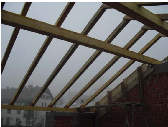
Slika 74: Ostrešje vrta – vidne grede in lege ter opaž za poševne vezi nadstropja (foto: Konda, 2011)
