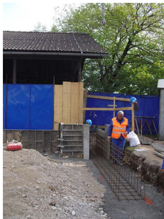
Slika 48: Polaganje armature in opaženje temeljev (foto: Konda, 2011)
