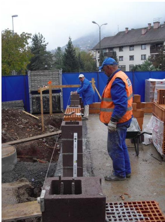
Slika 61: Zidanje zidov pritličja (foto: Konda, 2011)
