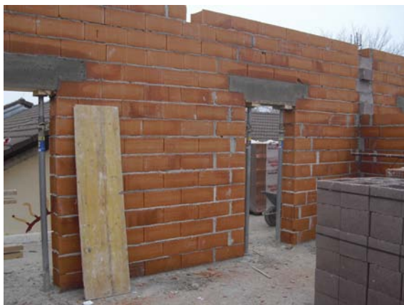
Slika 72: Opaž preklad nad vrati (foto: Konda, 2011)
