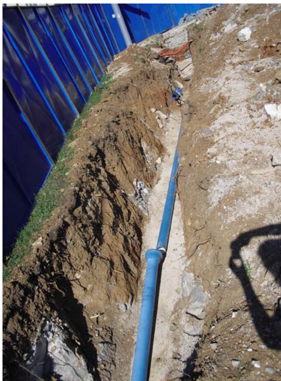
Slika 44: Priprava cevi za novo traso vodovoda (foto: Konda, 2011)
