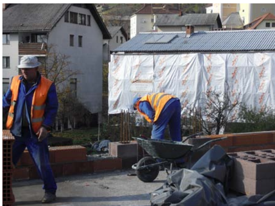
Slika 70: Zidanje zidov nadstropja (foto: Konda, 2011)
