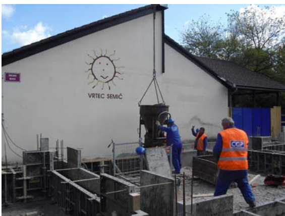
Slika 53: Betoniranje temeljev ob obstoječem vrtcu (foto: Konda, 2011)
