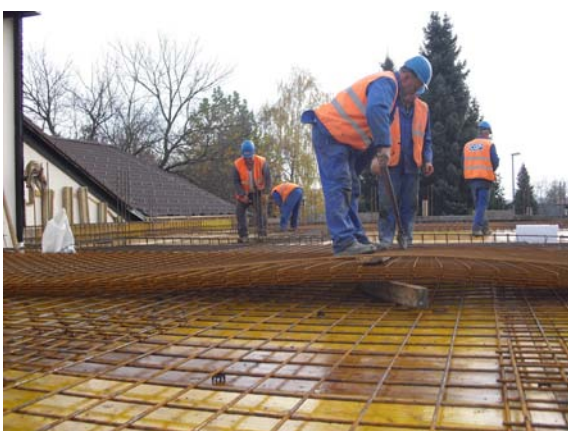
Slika 65: Polaganje armature za ploščo (foto: Konda, 2011)
