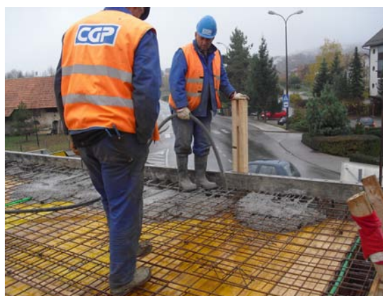
Slika 24: Vibriranje betona v vencu plošče (foto: Konda, 2011)
