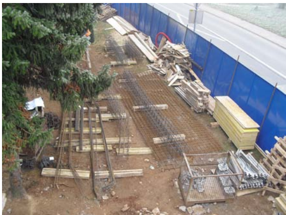
Slika 14: Deponija armature (foto: Konda, 2011)
