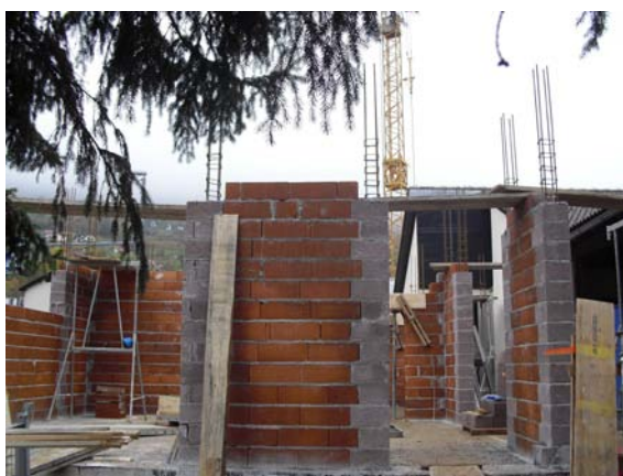
Slika 63: Prikaz puščene armature za nadstropje (foto: Konda, 2011)
