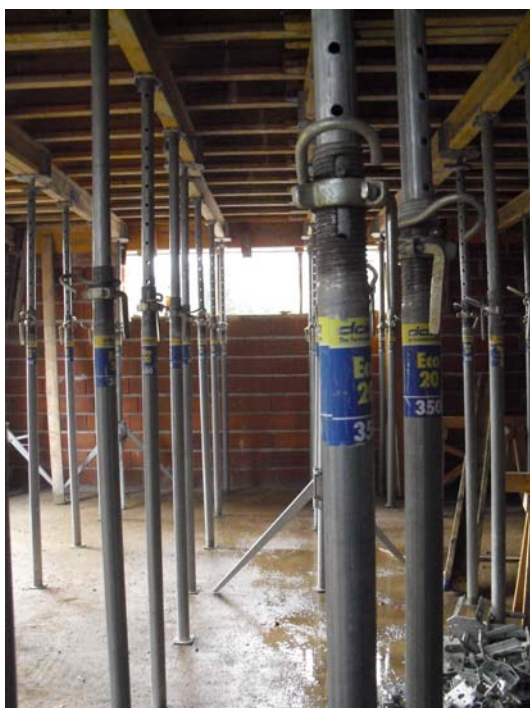
Slika 35: Opaž plošče (foto: Konda, 2011)
