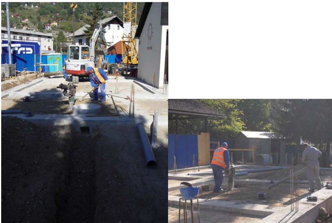
Slika 40: Polaganje cevi za kanalizacijo (foto: Konda, 2011)
