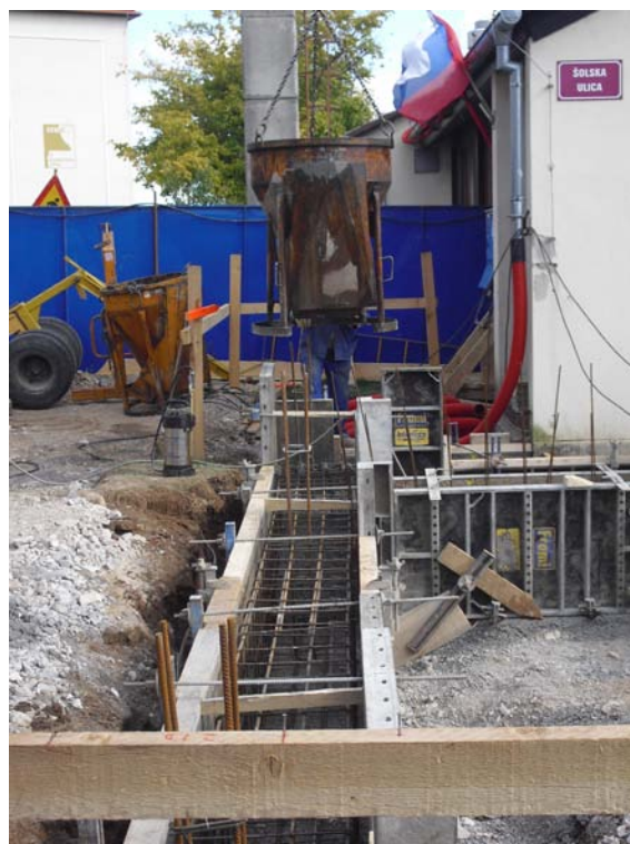
Slika 54: Betoniranje temeljev (foto: Konda, 2011)
