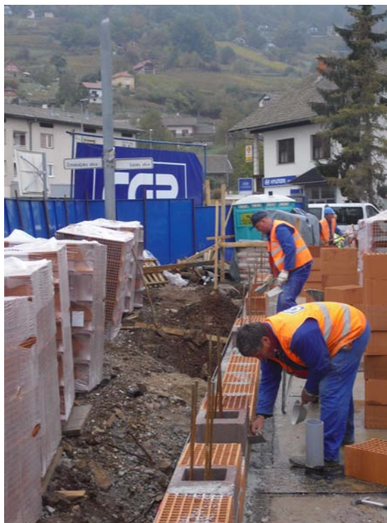
Slika 29: Zidanje nosilnih zidov vrtca (foto: Konda, 2011)
