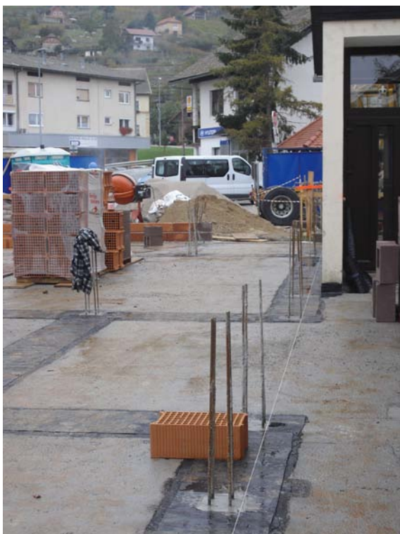
Slika 28: Začetek zidarskih del, vidna armatura za vertikalne protipotresne vezi (foto: Konda, 2011)
