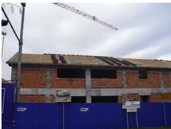
Slika 77: Prekrivanje strehe (foto: Konda, 2011)
