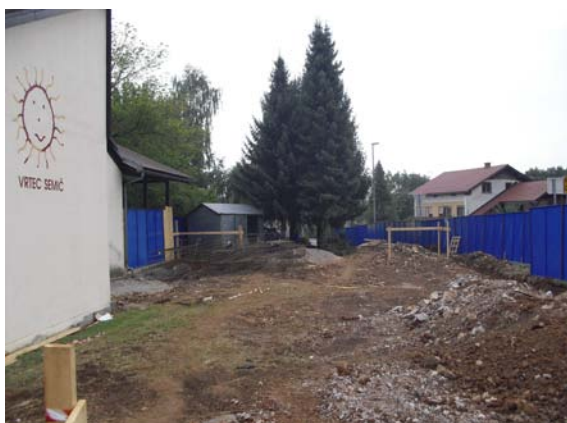
Slika 41: Pogled na začetno stanje na gradbišču, skrajno desno vidna nova trasa vodovoda (foto: Konda, 2011)
