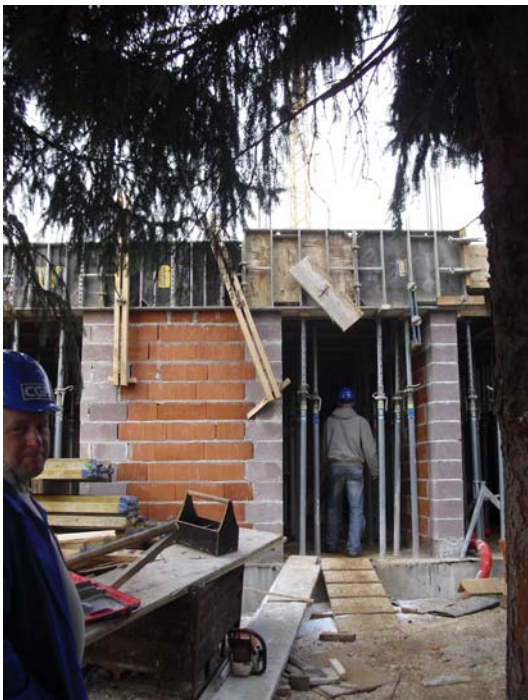
Slika 64: Opaž plošče (foto: Konda, 2011)
