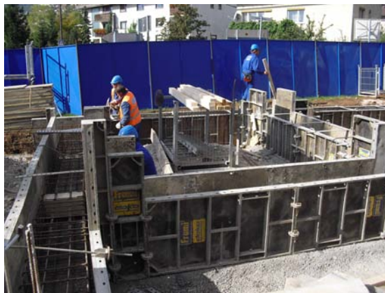
Slika 50: Opaženje temeljev (foto: Konda, 2011)
