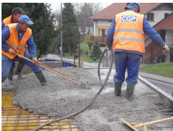
Slika 25: Zaključna obdelava betona na plošči (foto: Konda, 2011)
