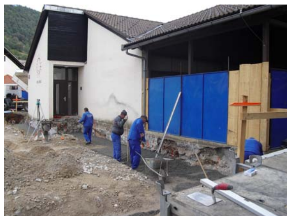
Slika 46: Polaganje podložnega betona za temelje (foto: Konda, 2011)
