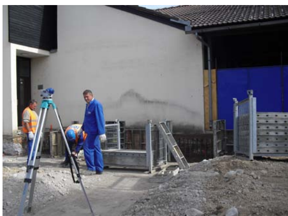
Slika 47: Na sliki vidni opaži temeljev in nivelir (foto: Konda, 2011)
