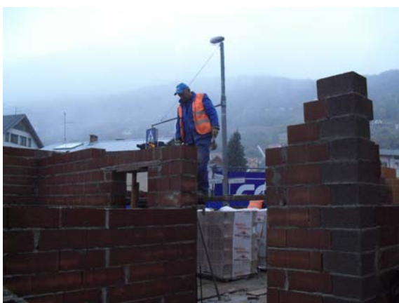
Slika 62: Zidanje zidov pritličja z uporabo odrov (foto: Konda, 2011)
