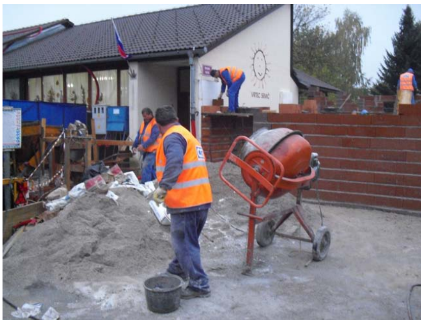
Slika 27: Prikaz mešanja malte (foto: Konda, 2011)
