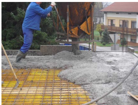
Slika 68: Izlivanje betona za betoniranje plošče (foto: Konda, 2011)
