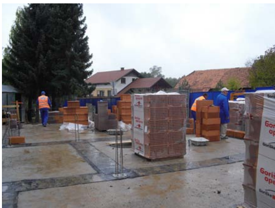
Slika 60: Začetek zidanja zidov pritličja (foto: Konda, 2011)
