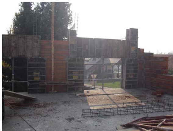
Slika 38: Opaž okenskih odprtin (foto: Konda, 2011)
