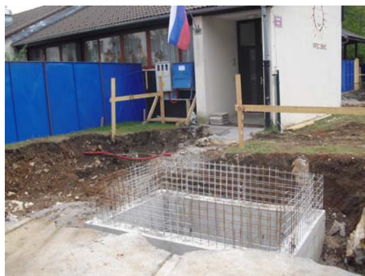
Slika 11: Vodomerni jašek v fazi gradnje (foto: Konda, 2011)
