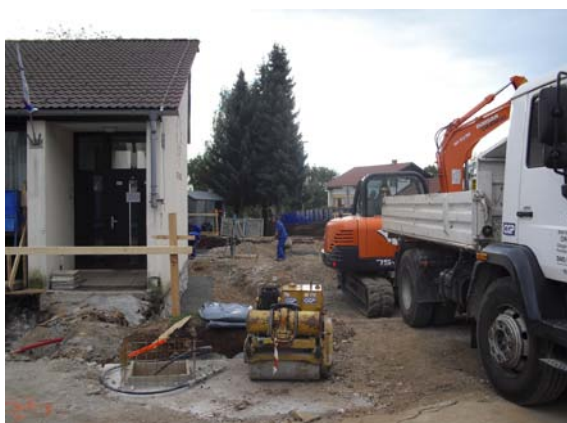
Slika 45: Izvajanje izkopov za temelje (foto: Konda, 2011)
