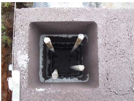
Slika 30: Detajl armature v vogalniku (foto: Konda, 2011)
