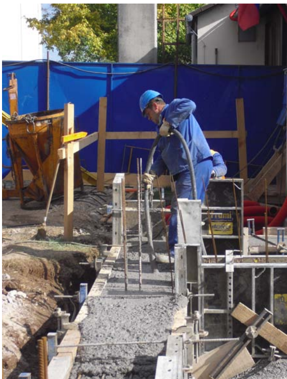
Slika 55: Vibriranje betona (foto: Konda, 2011)
