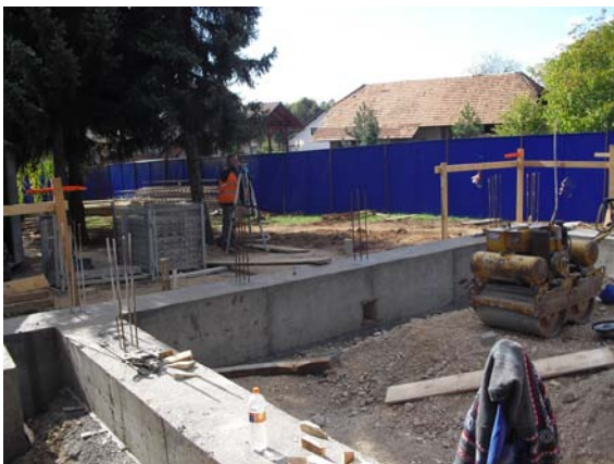
Slika 51: Delo z nivelirjem, prenos višin za vrh temeljev (foto: Konda, 2011)
