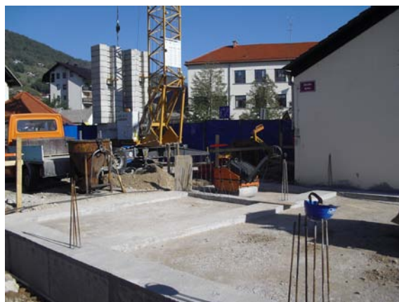
Slika 59: Utrjen nasip med temelji (foto: Konda, 2011)
