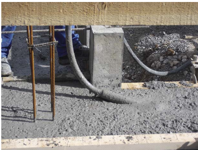
Slika 19: Kompaktiranje betona s pervibratorjem (foto: Konda, 2011)
