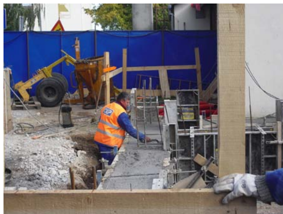
Slika 56: Glajenje betona (foto: Konda, 2011)
