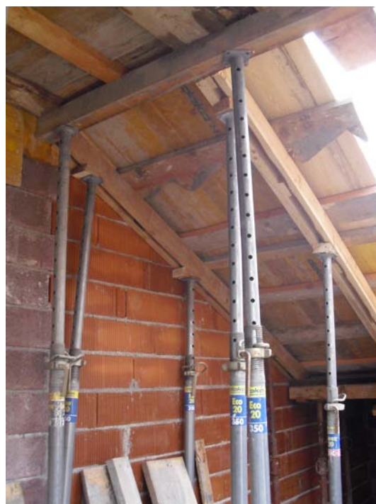
Slika 34: Opaž stopnic (foto: Konda, 2011)
