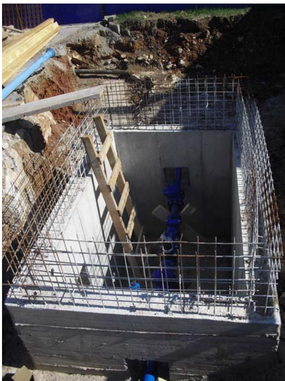
Slika 43: Vodomeri jašek s položenimi cevmi (foto: Konda, 2011)
