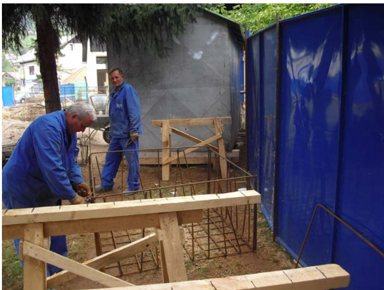
Slika 20: Vežanje armature (foto: Konda, 2011)
