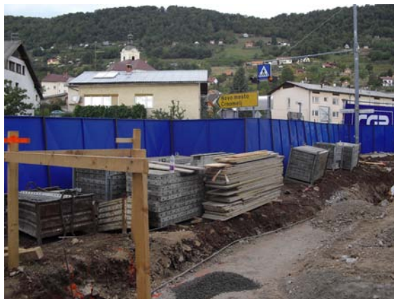
Slika 15: Deponiranje opažev za temelje (foto: Konda, 2011)
