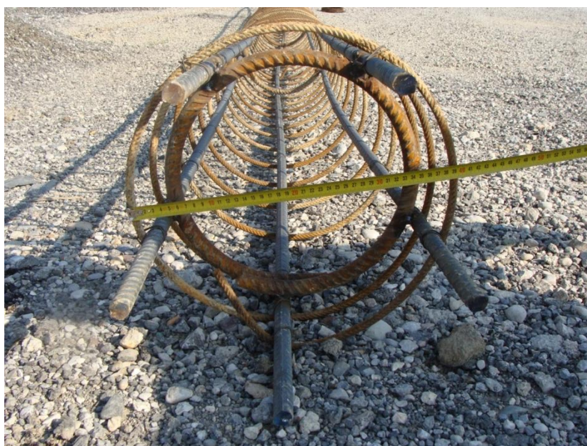
Slika 15: Armaturni koš pilota
