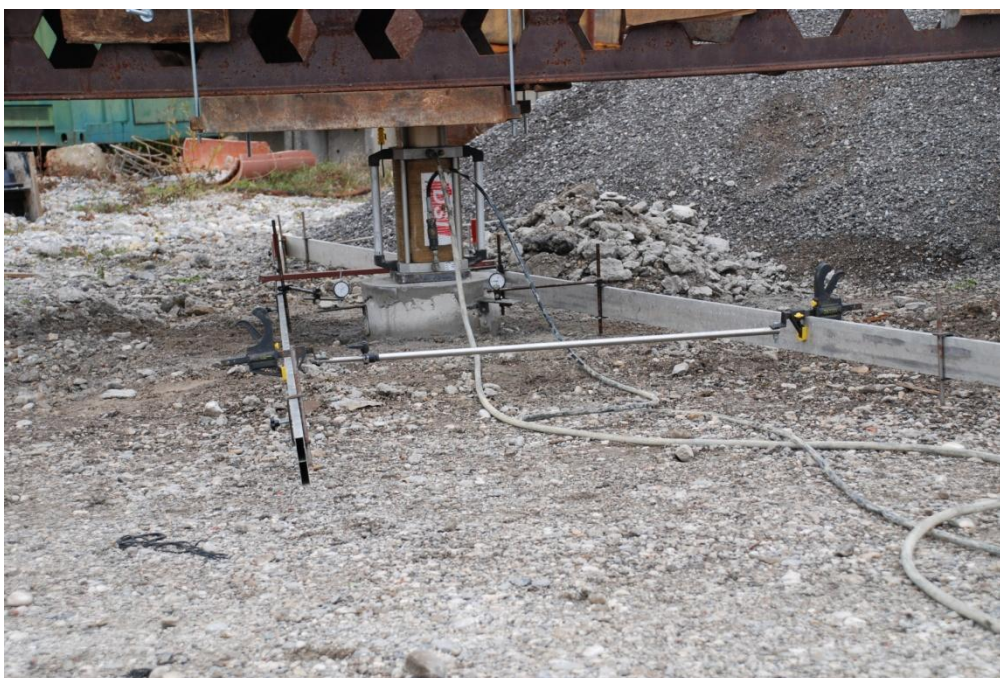
Slika 22: Priprava merilnih inštrumentov pred izvedbo statičnega obremenilnega testa
