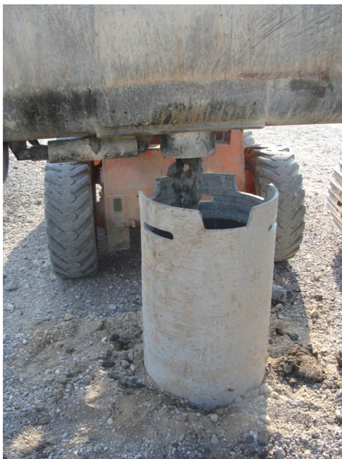
Slika 16: Betoniranje pilota z mešalno žlico
