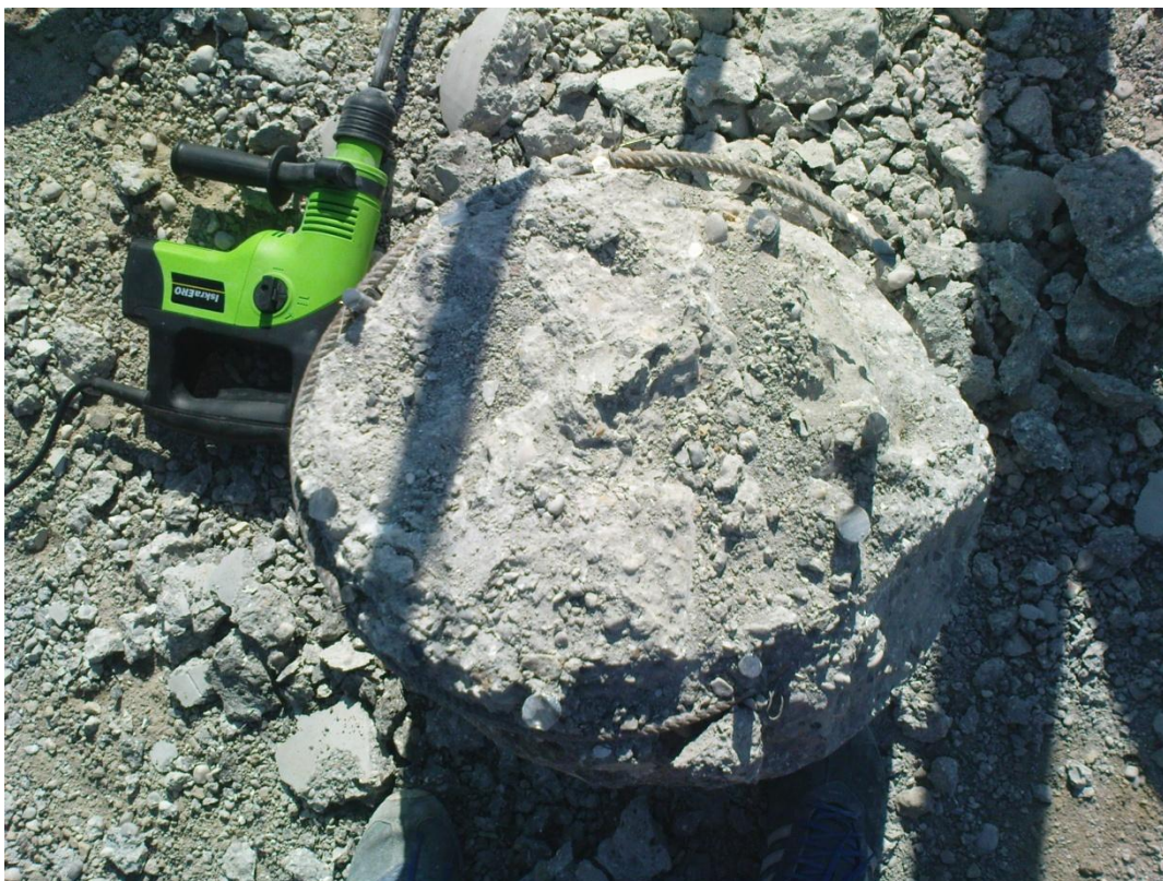
Slika 18: Ročno odstranjevanje kape pilota
