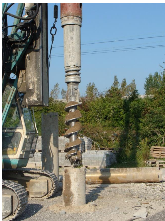
Slika 14: Izkop vrtine pilota z vrtnim strojem Casagrande dne 19.8.2011
