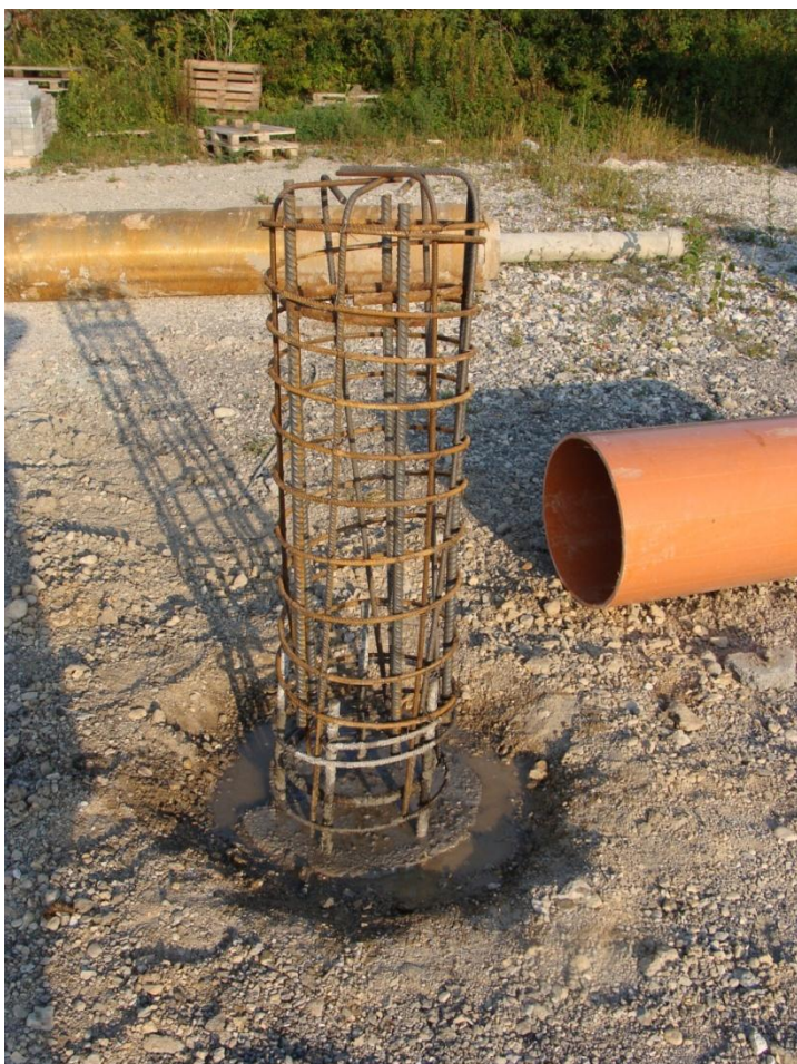
Slika 17: Armiranje kape pilota dne 27.8.2011
