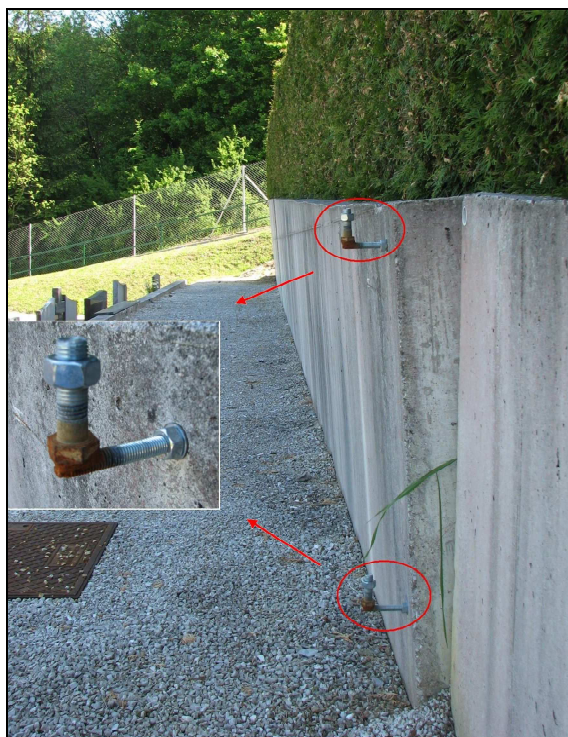
Slika 7: Stabilizacija kontrolnih točk
